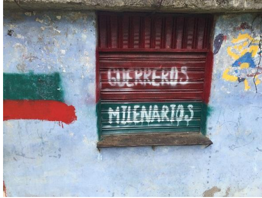
Fig. 12 – Caseta (Carretera Jambaló-Toribío, km 19). Fachada lateral. Detalle.
