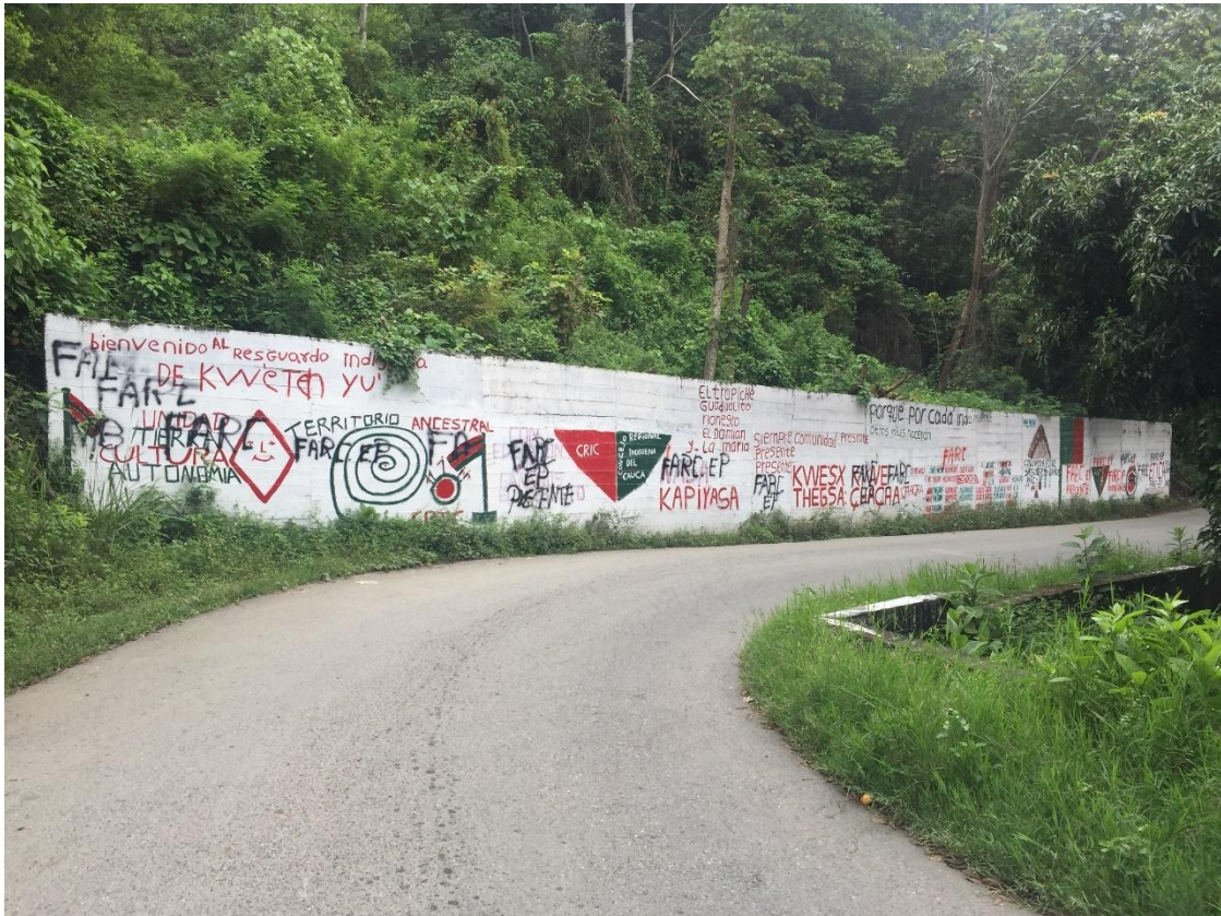
Fig. 8 - Muro de contención (Carretera El Palo-Toribío, km 13).
