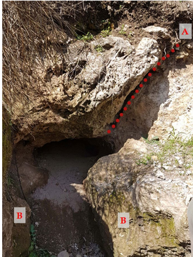
Fig. 1 – Ingresso attuale del riparo di Valle Stretta (Montelibretti, RM). In alto a destra uno dei blocchi di travertino crollati che ne costituivano l'aggetto roccioso. È evidente la profonda fessura (A puntinato) che costeggia il blocco scivolato (non completamente crollato) e che forma una discontinuità con la formazione travertinoso circostante. B: al centro, ai due lati dell'imboccatura della cavità (scavata successivamente alla frequentazione preistorica del sito), si trova la piroclastite pedogenizzata (livello archeologico).
