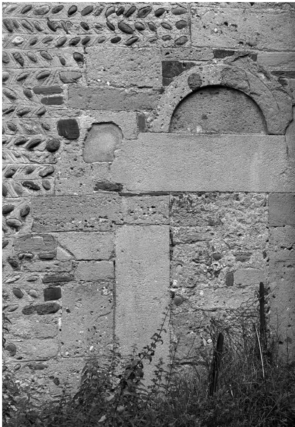
10. Brembate Sotto (Isola Bergamasca), località Grignano, San Fermo in Bedesco, parete sud. Il ceppo fluviale si alterna a ciottoli annegati nella malta stilata.
