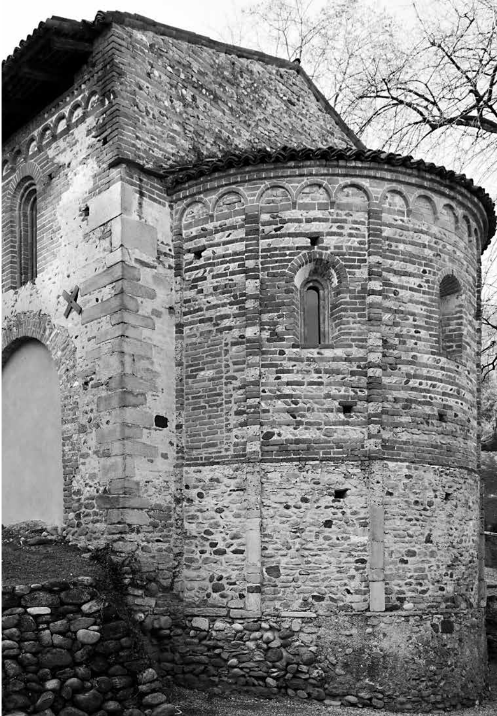
12. Gornate Olona (Varese), località Torba, ex monastero, chiesa di Santa Maria. La parte superiore dell'abside fu ricostruita non prima del tardo XII secolo.
