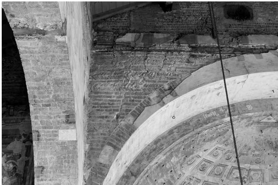
5. Il rinfiango absidale mostra fessurazioni e fuori piombo (da evento tellurico post 1117?), a mala pena contrastati dalla catena lignea.
