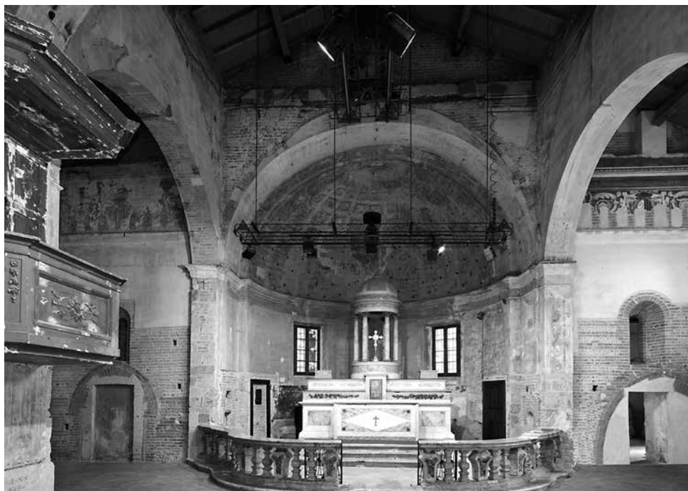
7. Presbiterio e transetto. Solo alcuni tratti dell'apparecchiatura di età romanica sono stati rimessi in luce sotto gli intonaci di età moderna.
