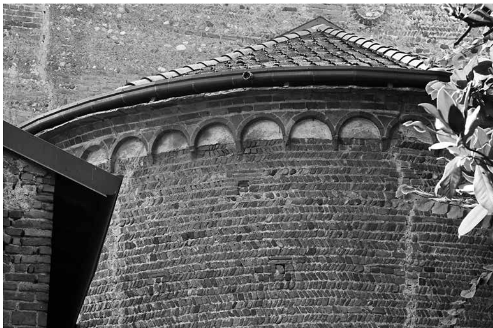
13. Chiesa vecchia di San Pietro all'Olmo, abside. La tessitura muraria fa uso quasi esclusivo di em- brici in opus spicatum .
