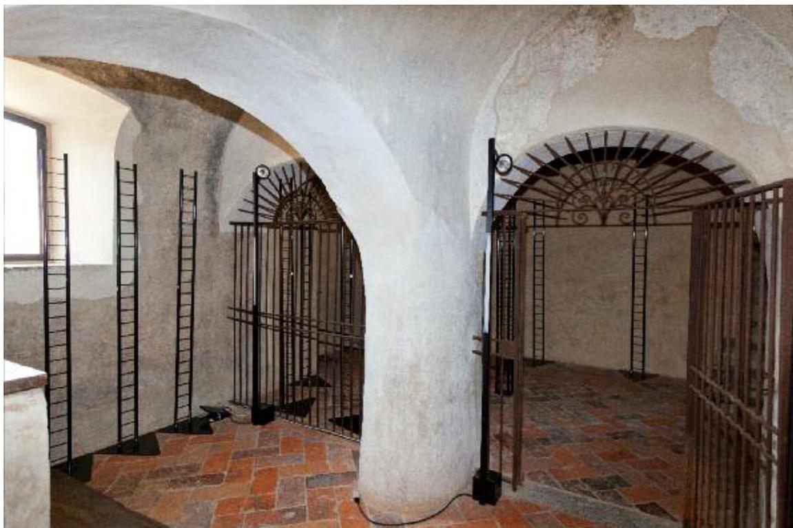
XXXI-XXXII. Il vano voltato della cripta di Fase 2b, da sudest e da nordest. Lo spesso pilastro pseudo-ellittico e il suo incerto raccordo con l'arcata longitudinale, così come l'accentuata falcatura delle arcate di valico rispetto alle volte a botte, fanno presumere il rimaneggiamento di un muro controterra con lesena sporgente (aprile 2014).
