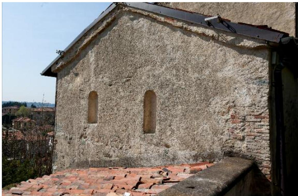
X. La testata del vano presbiteriale voltato. La luce semi-radente evidenzia il rattoppo murario che include le due monofore, occluse prima del 1571 (aprile 2014).
