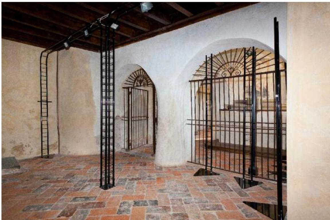
XXIX-XXX. Il corridoio/trincea, da nordovest e da sudovest. Le due arcate che immettono nel vano voltato furono ricavate in Fase 4, sbracciando il muro già controterra e trasformando la lesena centrale in pilastro oblungo. Contestualmente furono sottofondati i pilastri nordest e sudest della struttura cupolata (aprile 2014).
