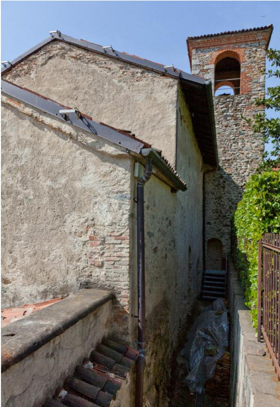
XIII. L'edificio da nordest. In evidenza, le diverse altezze dell'aula e del vano presbiteriale, la trincea scavata alla fine del secolo XIX per isolare il fianco dalla scarpata, la torre campanaria addossata alla campata occidentale (aprile 2014).
