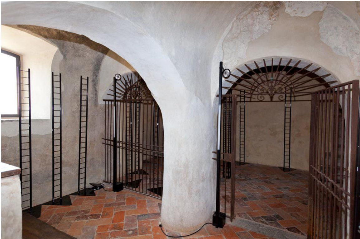
XXXI-XXXII. Il vano voltato della cripta di Fase 2b, da sudest e da nordest. Lo spesso pilastro pseudo-ellittico e il suo incerto raccordo con l'arcata longitudinale, così come l'accentuata falcatura delle arcate di valico rispetto alle volte a botte, fanno presumere il rimaneggiamento di un muro controterra con lesena (aprile 2014).
