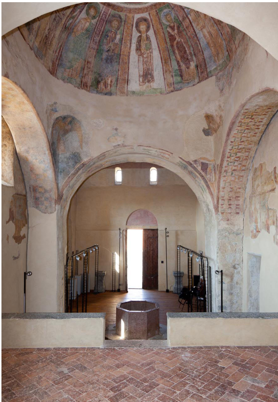
XVIII. L'interno, dalla piattaforma presbiteriale. In evidenza, la struttura della cupola, sorta di enorme ciborio autoportante, e il decoro figurativo radiale della calotta (aprile 2014).
