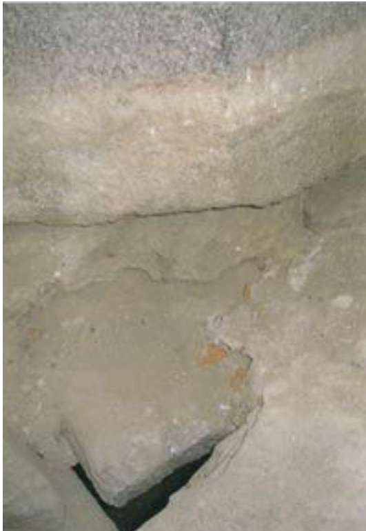
31. Barzanò, San Salvatore. Nel 2010, in occasione della rimozione del pavimento, fra la fondazione della ghiera del fonte battesimale (in alto) e quella della rampa di ascesa al presbiterio (in basso a sinistra) è riemerso un tratto del sarcofago «a vasca da bagno», coperto da lastre sconnesse. Già riscoperto nel 1892, se ne era persa memoria (da BASSANI 2013b).
