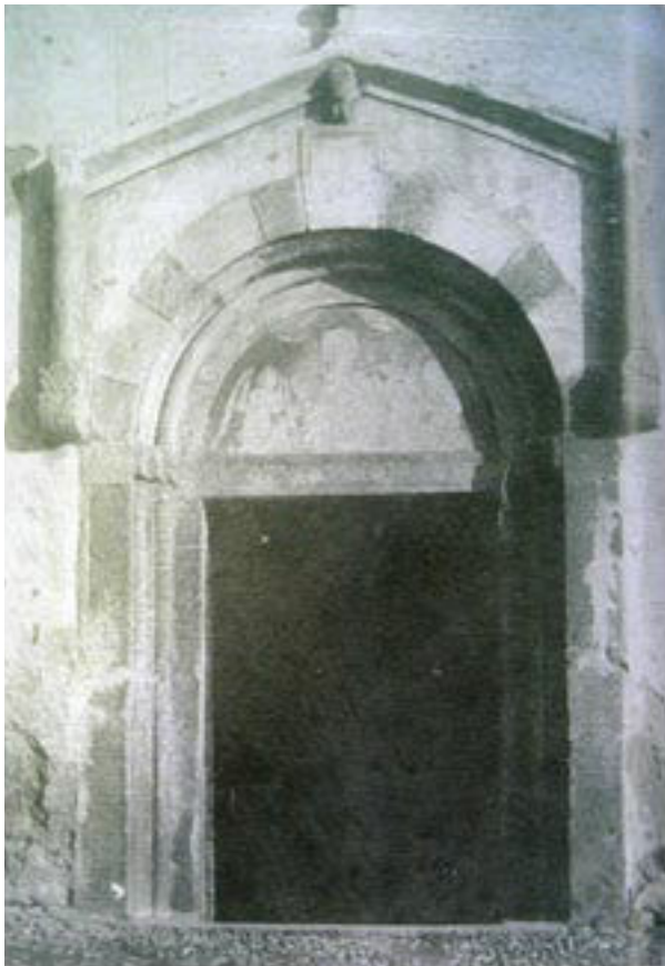
55. Barzanò, San Salvatore. La lunetta modanata del portale occidentale, con timpano/scossalina su colonnine. La studiata compresenza di serizzo, marmo bianco, arenaria e intonaco dipinto conferiva una spiccata policromia materica, in linea con la sensibilità tardoromanica (luglio 2016).
