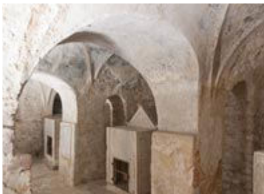
21. Pavia, San Felice, già San Salvatore. La cripta a corridoio occidentale di tardo VIII secolo, da sudovest, con pseudo-crociere ricavate dall'intersezione fra volte a botte e tre arche-reliquiario munite di mensa (aprile 2005).
