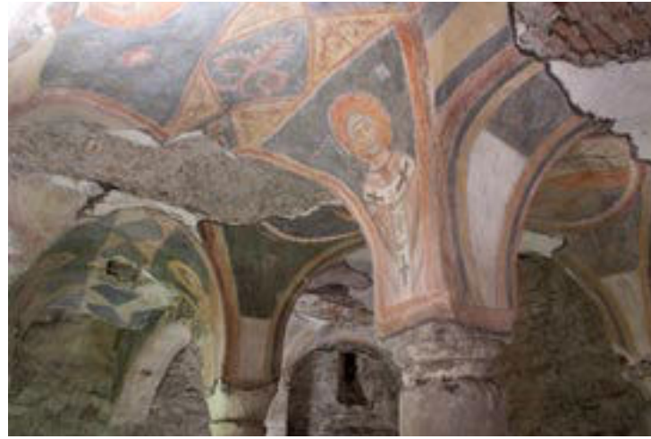
25. Pavia, San Giovanni Domnarum. Il sistema voltato del corridoio occidentale preromanico della cripta, con pseudo-crociere frutto dell'intersezione fra volte a botte. Il decoro dipinto risale al XII secolo (ottobre 2005).
