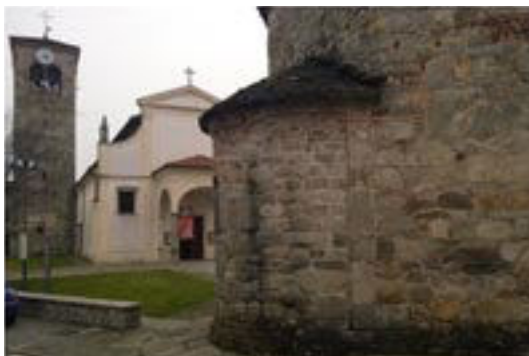
130. Cureggio (Novara), Santa Maria Assunta e aula battesimale di San Giovanni Battista. Nei resti del fonte ottagonale si stratificano la piscina seminterrata paleocristiana, la vasca di età romanica, il pozzetto di età moderna (novembre 2016).
