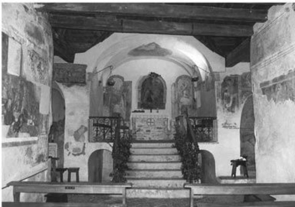
27. Belluno, San Daniele alla Pedeserva. La cripta quadrangolare seminterrata è accessibile mediante rampe perimetrali e si compone di uno pseudo-corridoio trasversale e due nicchioni (da FABBRI 2009 [2013]).
