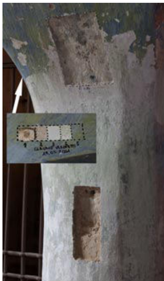
18. Barzanò, San Salvatore. Vano voltato della cripta, pilastro pseudo-ellittico. In evidenza, tre tasselli praticati il 19 marzo 2001 da Claudio Veschetti, occlusi nel corso del restauro 2009-2010 senza lasciare traccia. Quello del box al centro documenta cinque strati di finitura; i due del lato est del pilastro testimoniano l'incamiciatura di un più stretto supporto (maggio 2008).
