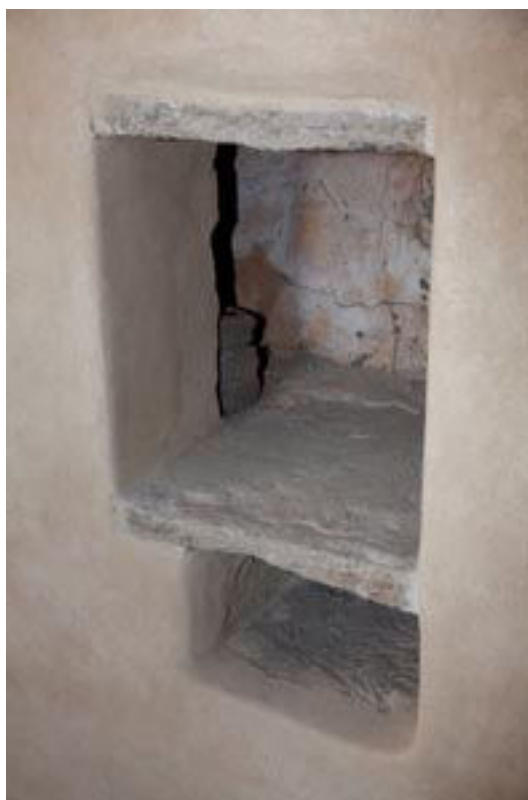
60. Barzanò, San Salvatore. Vano presbiteriale, parete nord, la doppia nicchia di conformazione irregolare (aprile 2014).
