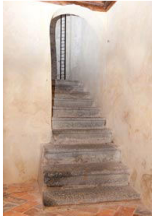
50. Barzanò, San Salvatore. La rampa nord, dal corridoio/trincea, con i primi tre gradini più larghi dei precedenti (aprile 2014).
