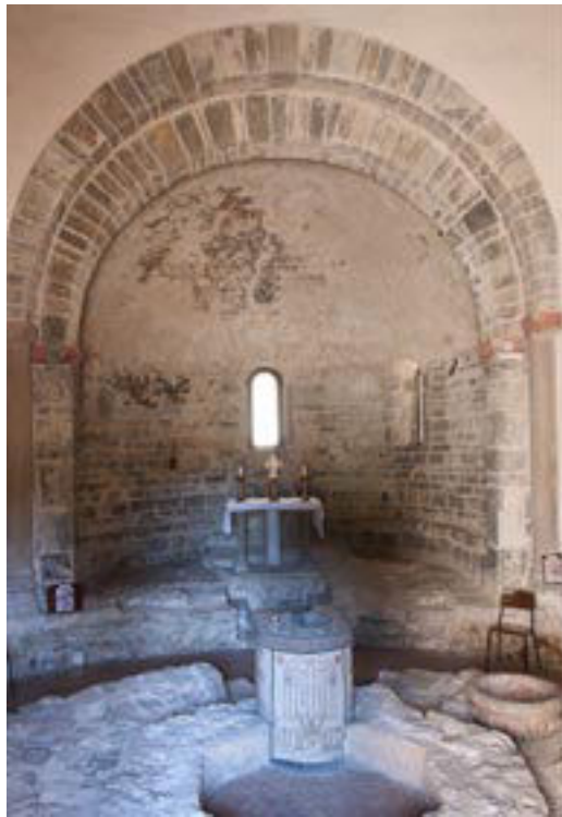
69. Oggiono (Lecco), aula battesimale di San Giovanni Battista. L'abside a doppia ghiera inquadra la base in muratura del fonte ottagonale di età romanica (agosto 2004). La sezione (da SPREAFICO 2003) evidenzia la stratificazione dei piani pavimentali e il cilindro in muratura su cui poggia il fonte.
