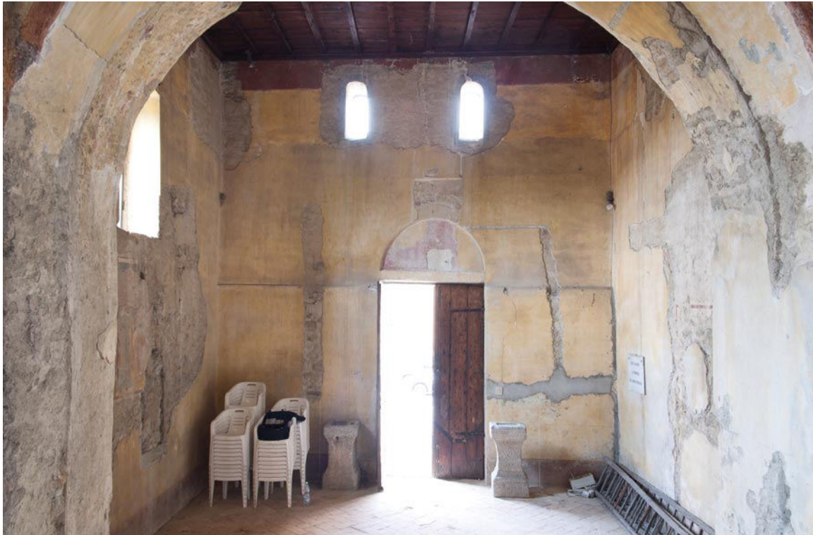
XIX. La campata occidentale, poco prima che cominciassero i lavori di restauro. Ai lati del portale, le due arcate di età romana (maggio 2008).
