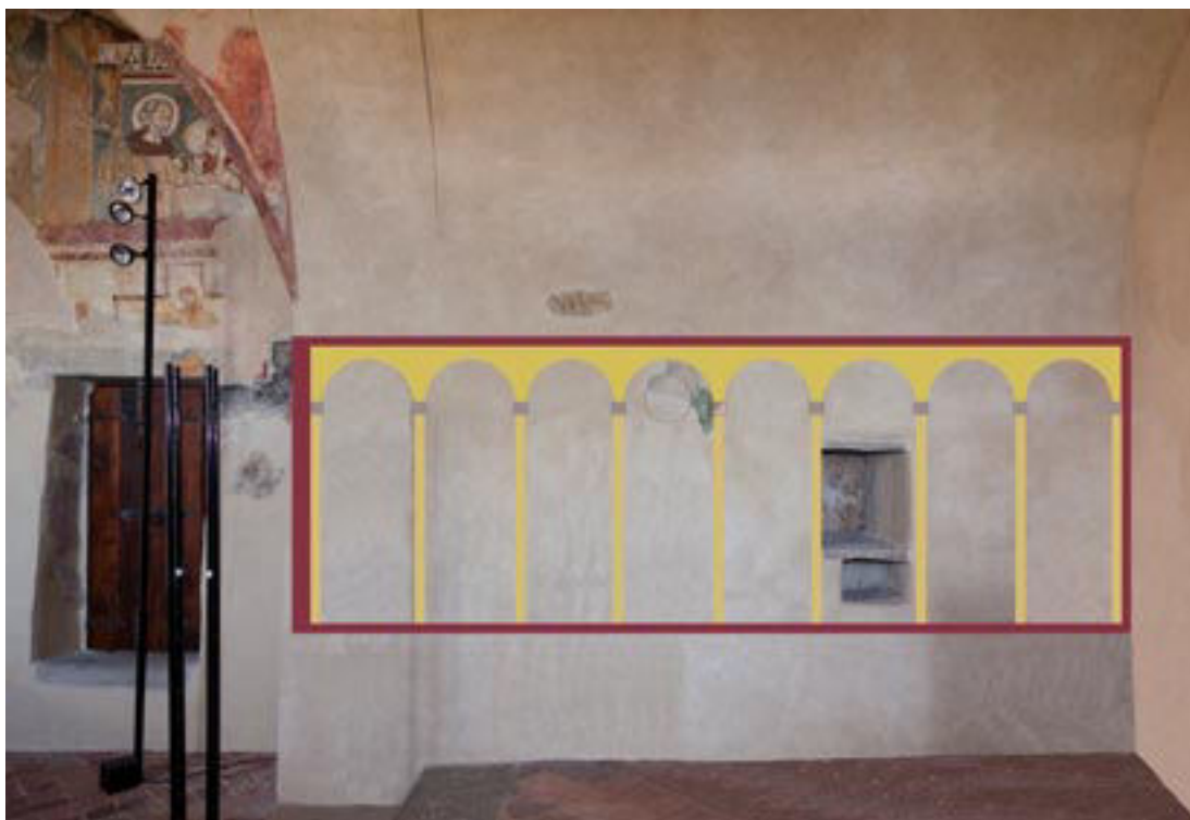
96. Barzanò, San Salvatore. Vano presbiteriale, parete nord. Proposta di restituzione della sequenza di arcate che si presume accogliessero gli apostoli e/o la Vergine/angeli/santi.
