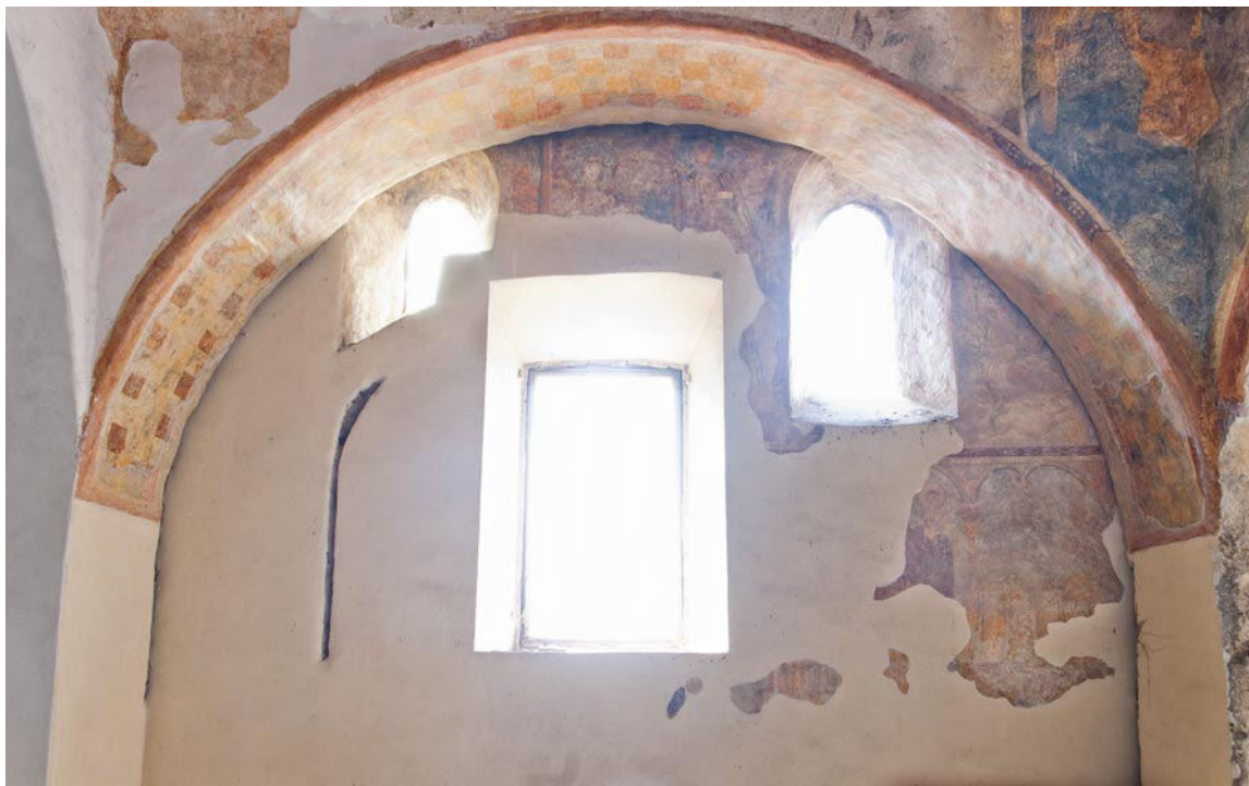
XXV. Il perimetrale sud della campata cupolata. Pur intersecate dall'arcata, le due monofore di Fase 1 restarono in uso, come dimostrano gli sguinci dipinti in fase con le storie dell'Infanzia di Cristo. Prima dell'apertura del finestrone tardorinascimentale la monofora sinistra era già stata 'spostata' più in basso (luglio 2004).
