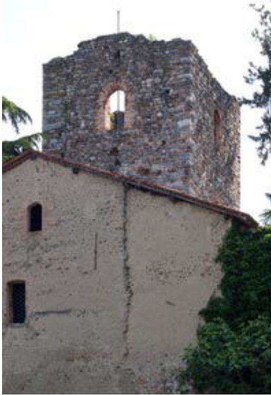
2. Il cosiddetto «torrione», nel giardino di casa (già) Nava, distante 120 m da San Salvatore, unica testimonianza visibile del «castello». L'apparecchiatura, in pietre sborzate ben disposte e con elementi squadrate per i cantonali, è inquadabile nel secolo XIII (maggio 2008).
