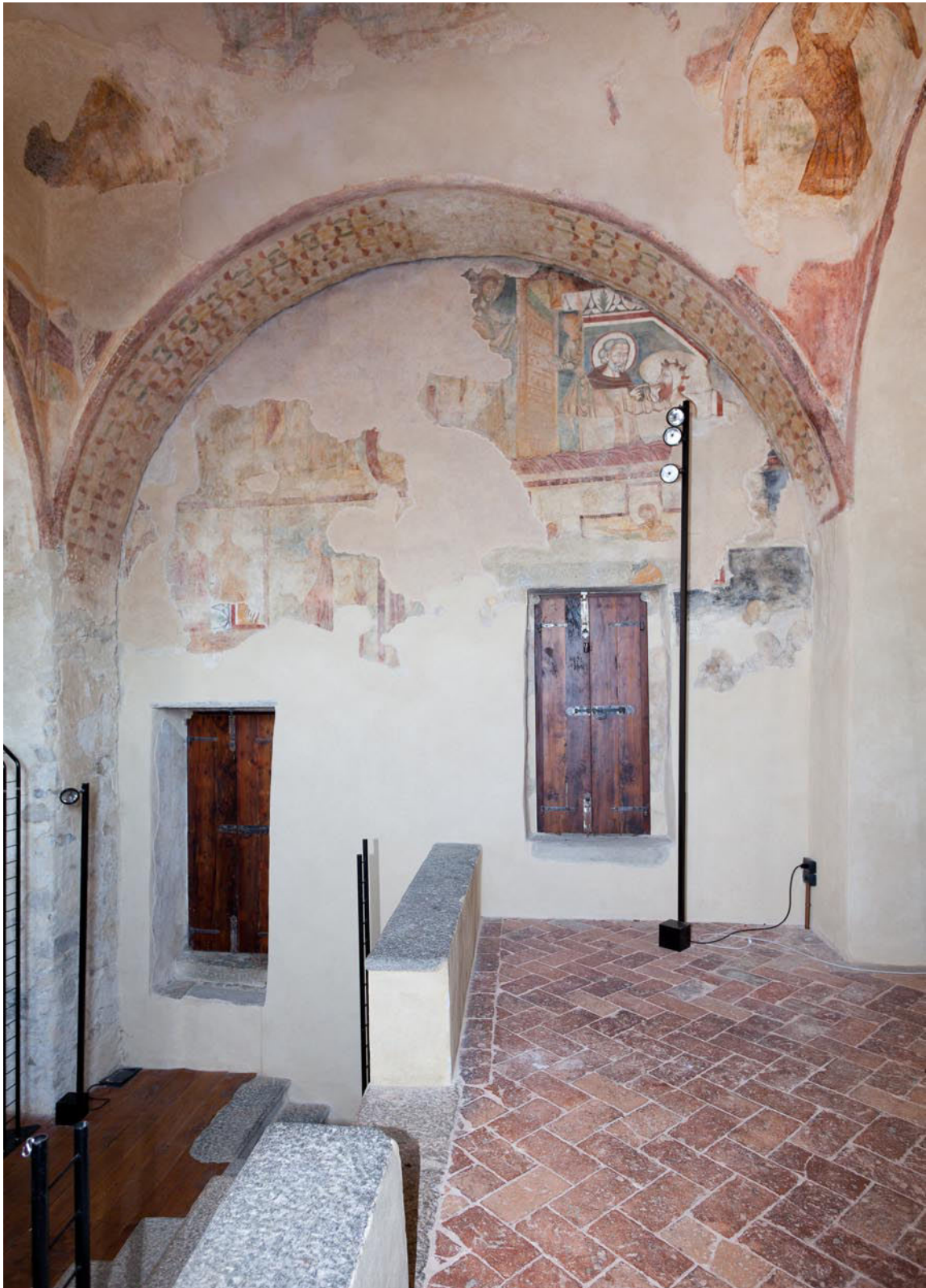
XXIV. Il perimetrale nord della campata cupolata. Il varco all'estremità sinistra fu probabilmente aperto in Fase 3, anche in funzione del fonte battesimale; quello a destra fu ricavato tempo dopo, in rottura del decoro romanico. I pochi lacerti dipinti lasciano individuare due registri sovrapposti, recanti scene della vita pubblica di Cristo, non chiaramente identificabili. A cavallo dei secoli XIII e XIV lo strato dipinto fu in gran parte ricoperto da un riquadro sub-rettangolare recante soggetti devozionali: nell'unico lacerto figurativo rimasto, un frate (?) santo nutre un indigente (aprile 2014).
