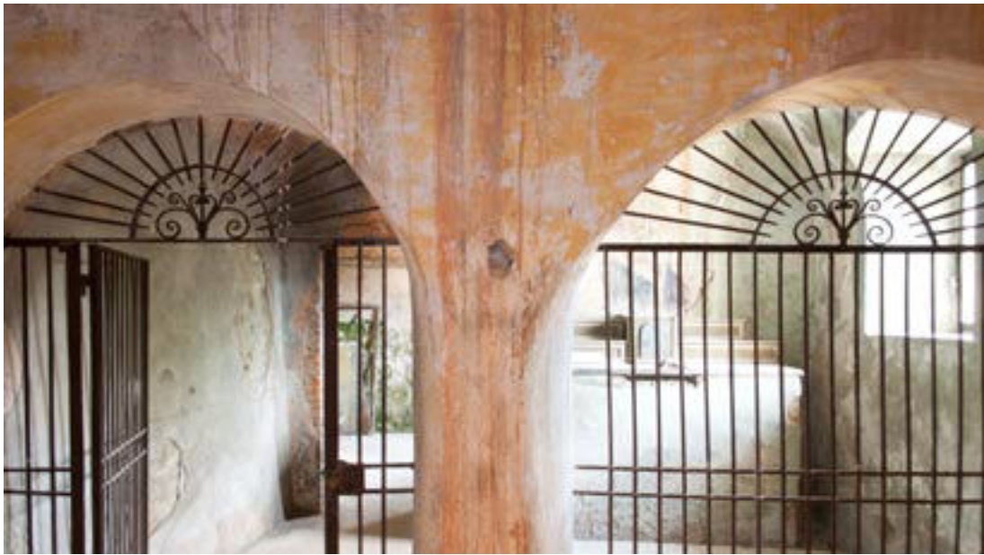
6. Barzanò, San Salvatore. Fronte del vano voltato della cripta, prima dell'intonacatura di restauro. Le due arcate di valico furono quasi certamente ricavate in Fase 4 sbrecciando il muro già controterra, demolendo le primitive scale di discesa e occludendone i varchi, di cui resta traccia alle estremità superiori dell'inquadratura (maggio 2008).
