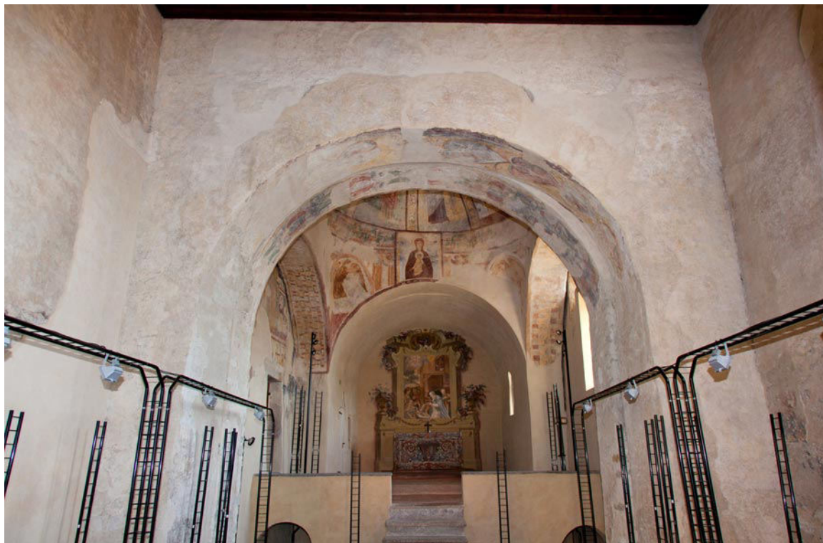
XX. L'arcata di valico, già facciata di Fase 1. Il restauro ha rimesso in luce i resti di due monofore (aprile 2014).
