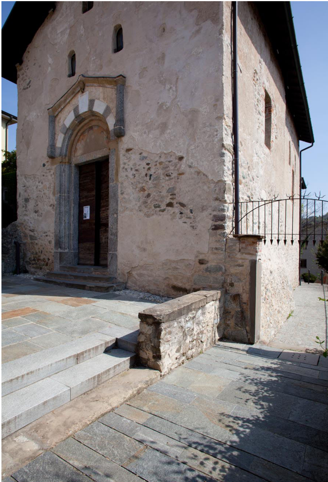
VIII. L'angolo sudovest dell'edificio. In evidenza, il digradare nord-sud del sagrato e il muretto in linea con quello di terrazzamento di Fase 2b, documentato per una lunghezza di 24 m (aprile 2014).
