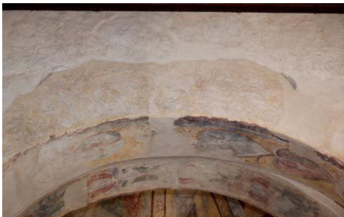
4. Barzanò, San Salvatore. La parte sommitale dell'arcata di valico, ricavata sbrecciando in Fase 2b la facciata di Fase 1. Il restauro 2009-2010 ha rimesso in luce i profili degli archi di due monofore (aprile 2014).
