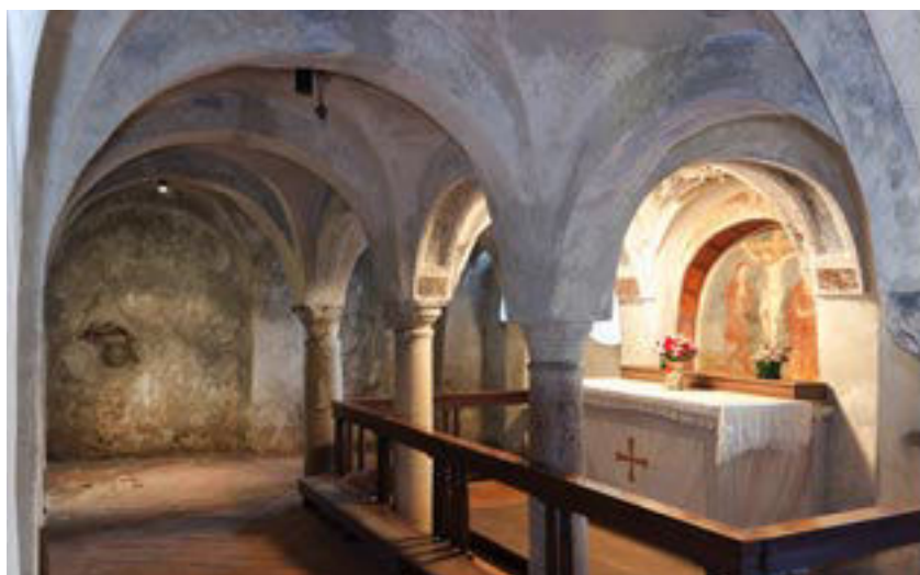
28. Almenno San Salvatore, antica pieve di San Salvatore. Fianco sud dell'aula a tre navate e del presbiterio su cripta-sostruzione (giugno 2010). La cripta ad impianto trasversale, servita da scale longitudinali e coperta da sei crociere su tre colonne e lesene perimetrali (agosto 2008). Attorno al Mille.
