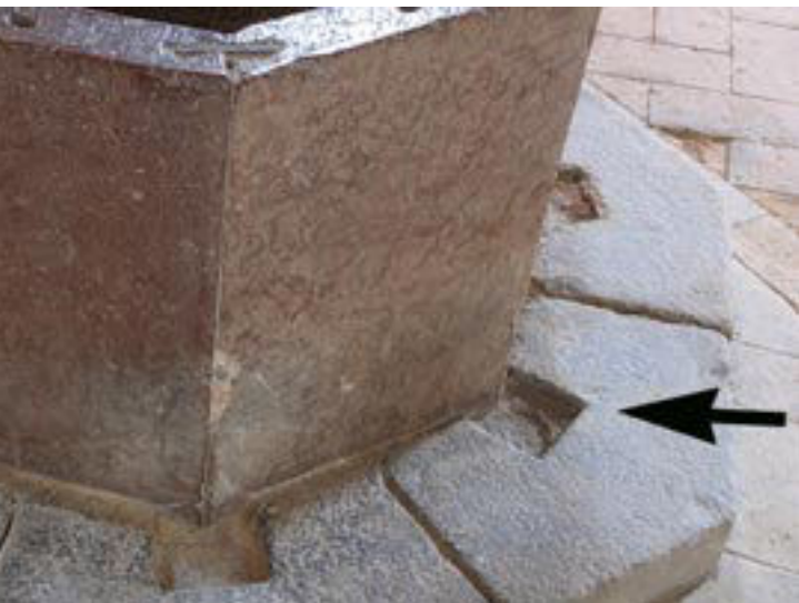
67. Barzanò, San Salvatore. Fonte battesimale, dettaglio della ghiera a spicchi di serizzo. La freccia segnala lo scasso a coda di rondine nordovest, che conserva l'impronta in malta rosata di un base circolare (luglio 2016).
