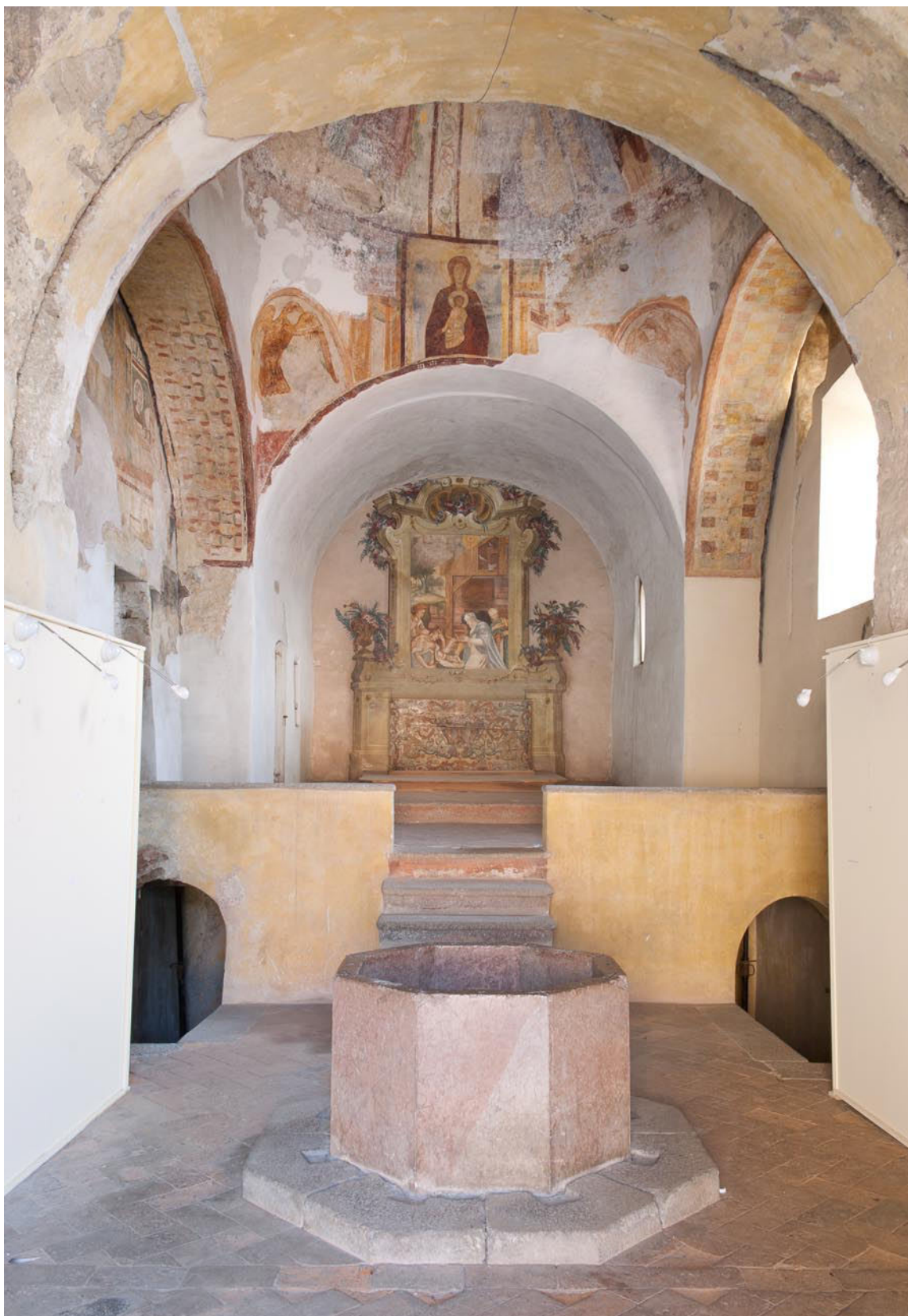
XVII. L'interno, dalla controfacciata. La pavimentazione in cotto è stata sostituita nel 2010 da un assito ligneo, già deformato dall'umidità. In primo piano, il fonte battesimale ottagonale, in asse con la cupola dipinta e con la rampa di accesso al presbiterio, ai lati della quale si aprono i varchi che conducono al livello inferiore (luglio 2004).
