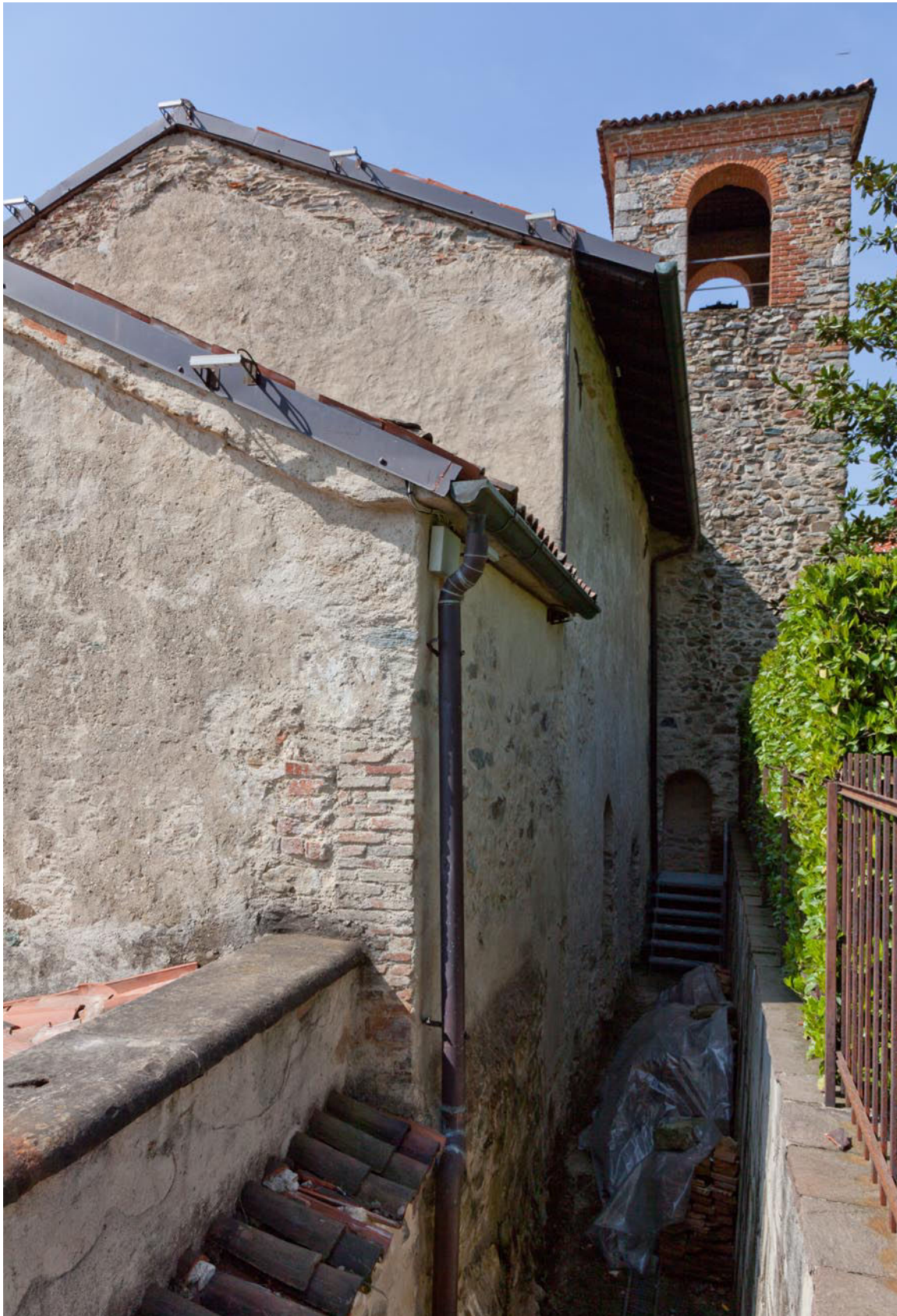
XIII. L'edificio da nord-est. In evidenza, le diverse altezze dell'aula e del vano presbiteriale, la trincea scavata alla fine del secolo XIX per isolare il fianco dalla scarpata, la torre campanaria addossata alla campata occidentale (aprile 2014).
