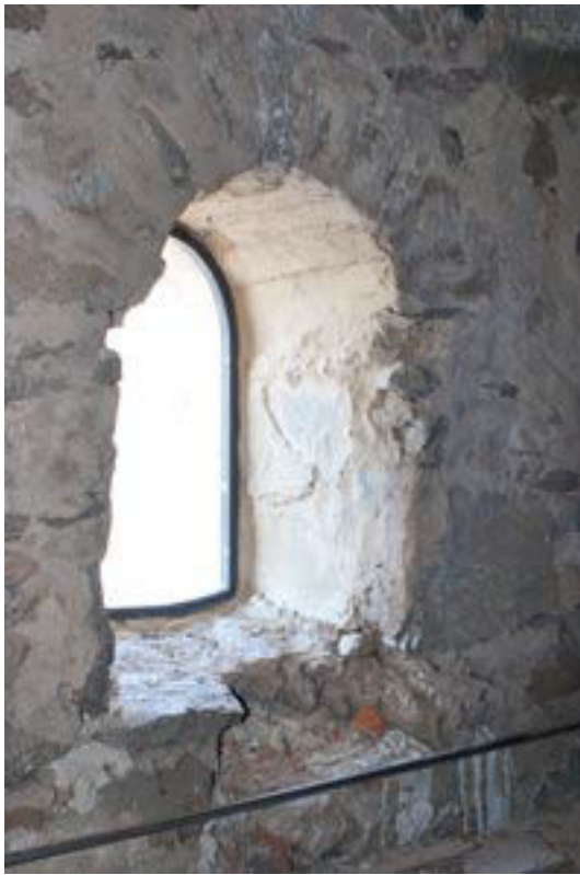
17. Barzanò, San Salvatore. La monofora sommitale della facciata di Fase 2b, dal sottotetto. In evidenza, il profilo incerto e le impronte lasciate sulla malta dalla cèntina (maggio 2008).
