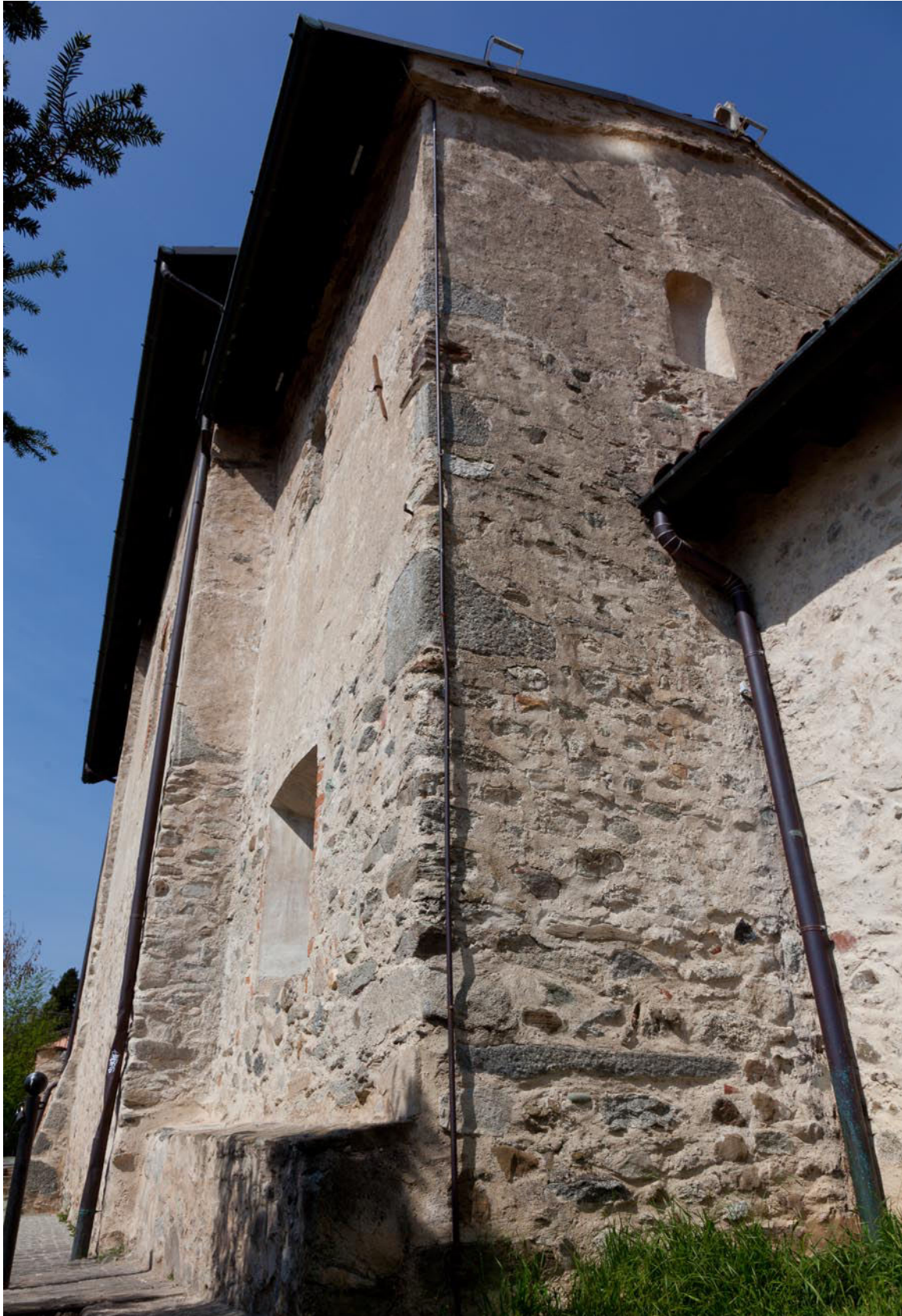
XI. Lo spigolo sudest dell'edificio. Le poche pietre sbazzate o squadrate disponibili furono concentrate nei cantonali, per aumentarne la stabilità (aprile 2014).
