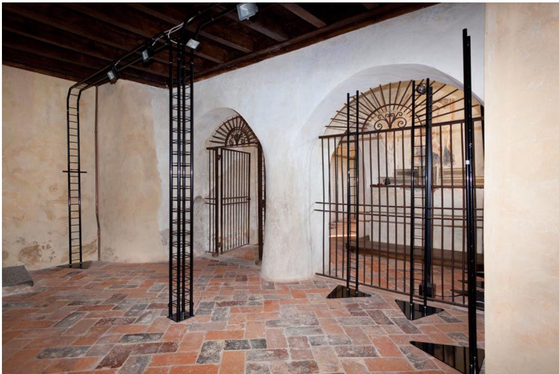
XXIX-XXX. Il corridoio/trincea, da nordovest e da sudovest. Le due arcate che immettono nel vano voltato furono ricavate in Fase 4, sbrecciando il muro già controterra e trasformando la lesena centrale in pilastro oblungo. Contestualmente furono sottofondati i pilastri nordest e sudest della struttura cupolata (aprile 2014).
