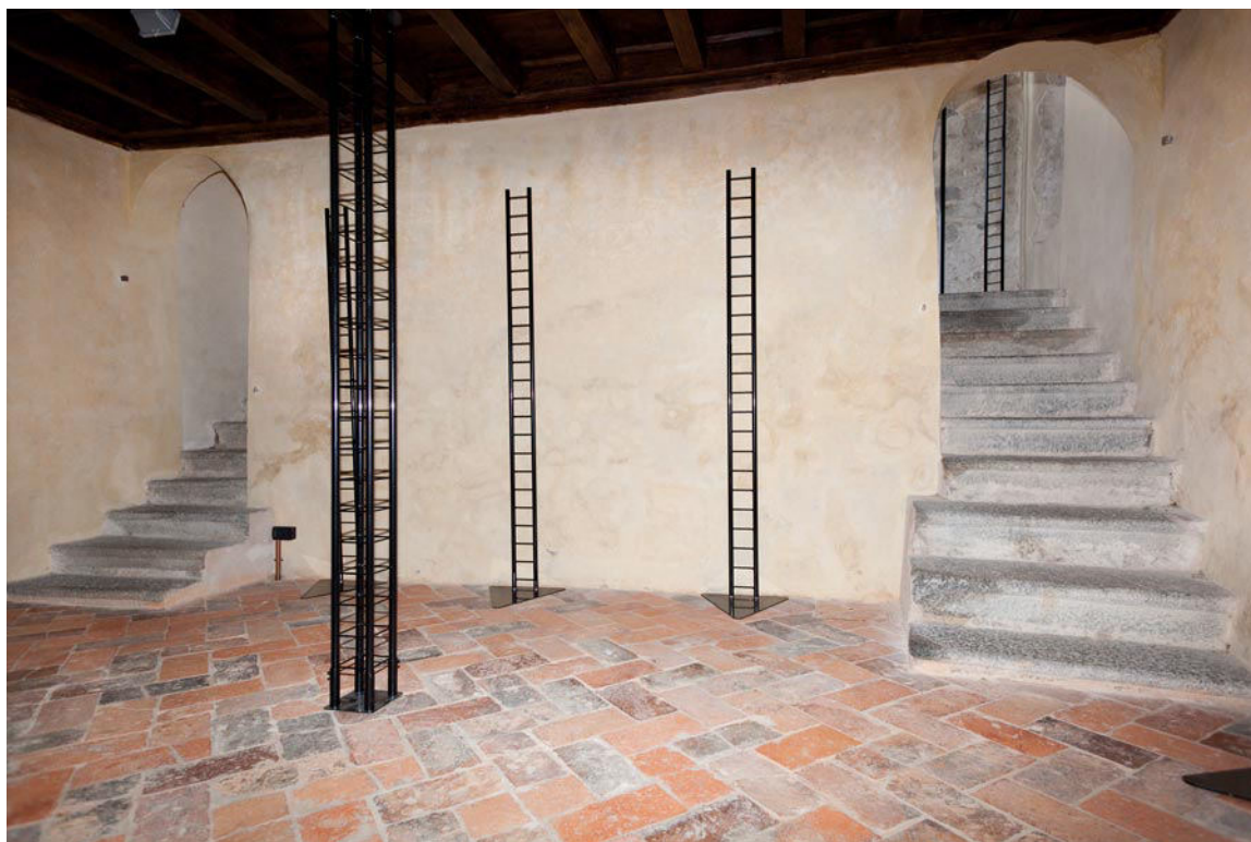
XXVIII. Il corridoio/trincea, scavato in Fase 4 per ampliare la piattaforma presbiteriale e la cripta, ripreso da est. In evidenza: il muro controterra, le rampe perimetrali, la soletta lignea (aprile 2014).
