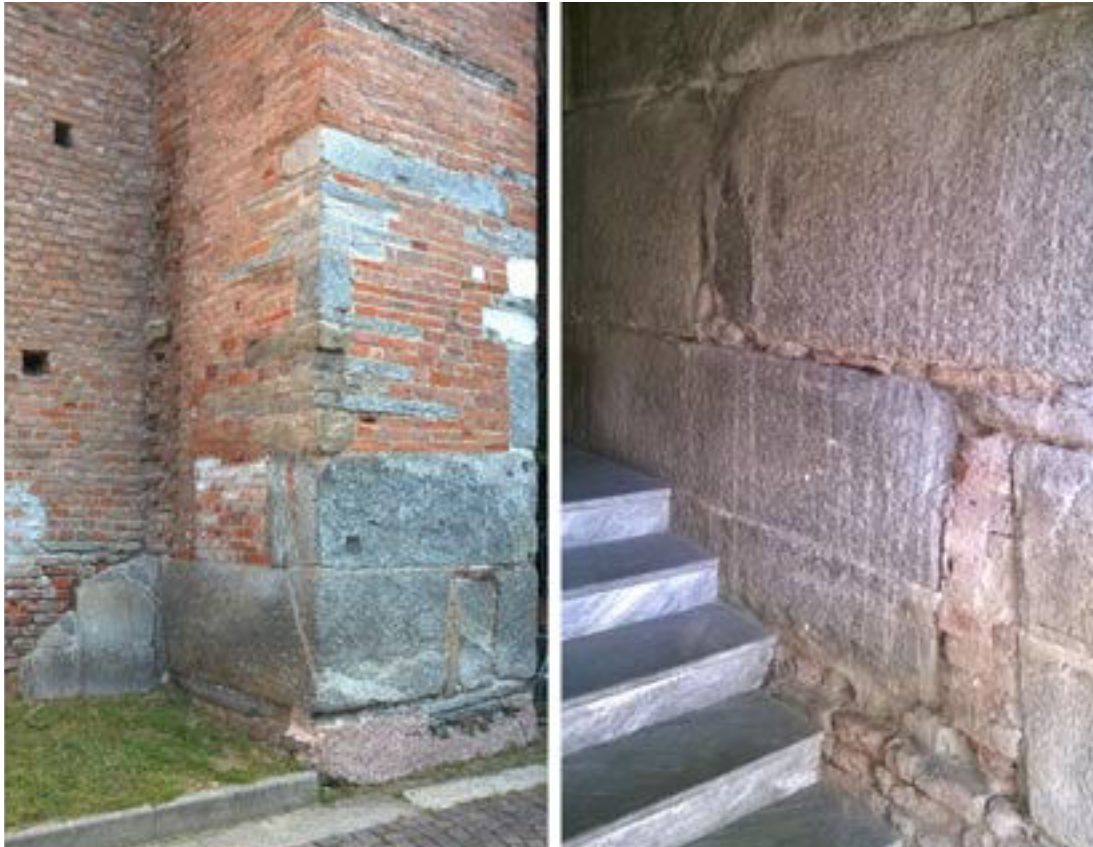
37. Milano, San Simpliciano. Perimetrale sud, a ridosso del transetto, e base della torre romanica: casi esemplari di sarcofagi ruotati sul fianco, riempiti di materiale eterogeneo e reimpiegati alla base della muratura (aprile 2016).
