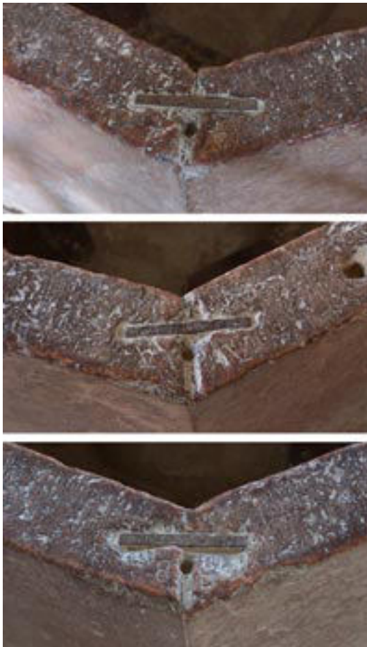
64. Barzanò, San Salvatore. Fonte battesimale, dettagli del bordo superiore delle lastre, in corrispondenza delle giunzioni. Le grappe metalliche e la segnaletica di montaggio erano destinate ad essere celate da un cornicione (maggio 2008).
