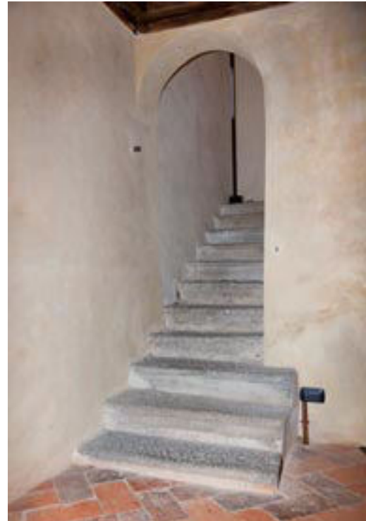
52. Barzanò, San Salvatore. La rampa sud, dal corridoio/trincea, con i primi tre gradini più larghi dei precedenti (aprile 2014).
