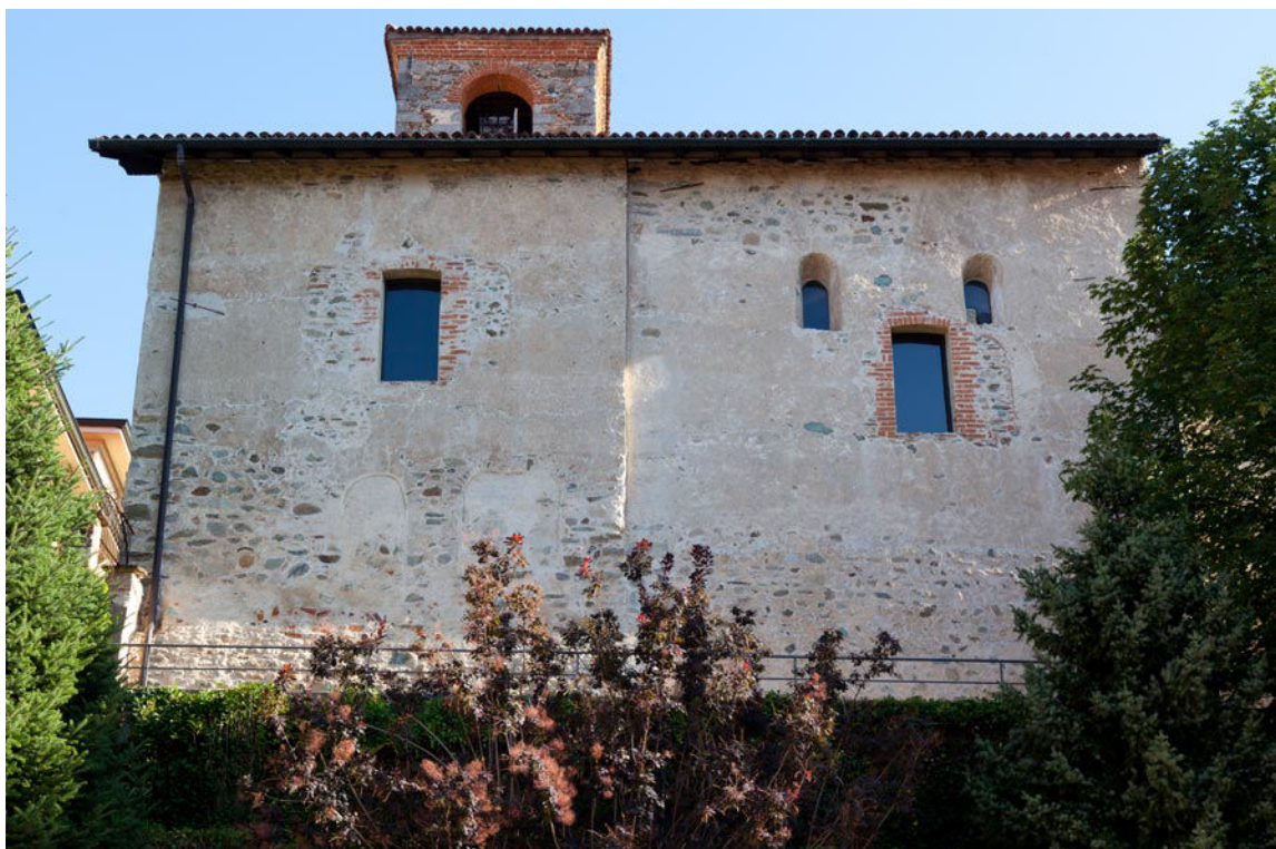
IX. Il prospetto meridionale. In evidenza, la discontinuità fra le due campate e la stratificazione delle aperture (luglio 2016).
