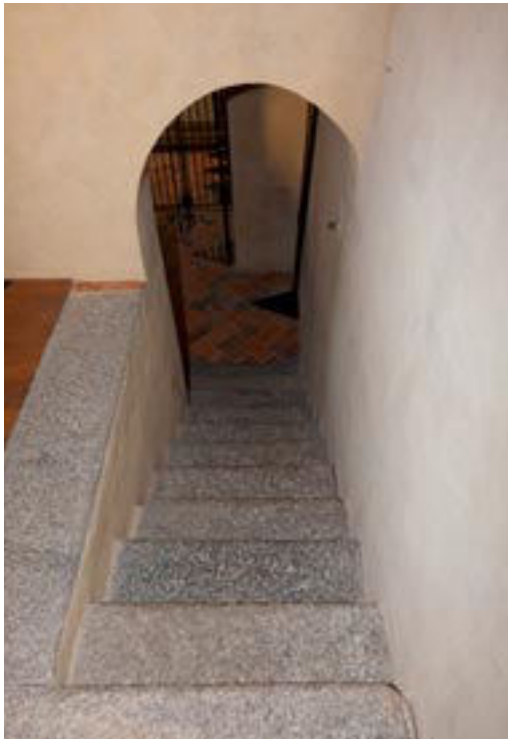
51. Barzanò, San Salvatore. La rampa di dieci gradini addossata al perimetrale sud, dall'aula in direzione del corridoio/trincea (aprile 2014).
