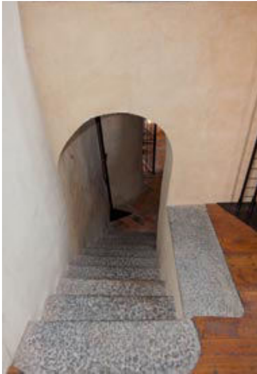
49. Barzanò, San Salvatore. La rampa di nove gradini addossata al perimetrale nord, dall'aula in direzione del corridoio/trincea (aprile 2014).
