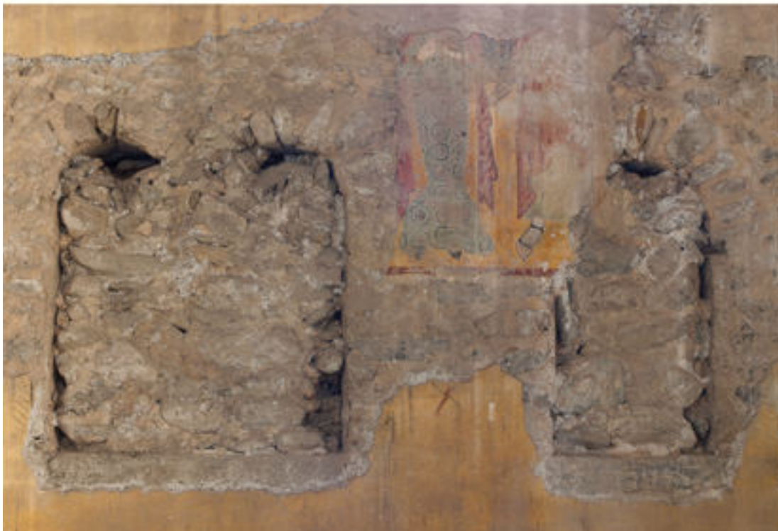
15. Barzanò, San Salvatore. Il gruppo bifora-monofores del perimetrale sud della campata occidentale, dall'esterno (aprile 2014) e dall'interno (maggio 2008). Le aperture furono occluse intorno alla fine del secolo XIII, per dipingervi sopra una sequenza di figure.
