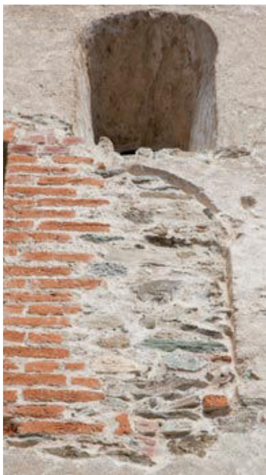
10. Barzanò, San Salvatore. Stratificazione di aperture nel perimetrale sud della campata centrale. In alto, la monofora 'a fungo' di Fase 1; sotto, la monofora bassomedievale occlusa in occasione dell'apertura del finestrone di età moderna, di cui è visibile la spalletta laterizia (aprile 2014).
