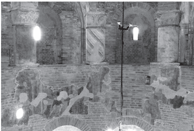
11. Mantova, San Lorenzo: ambulacro superiore, pilastri cilindrici marmorizzati e capitelli dipinti a palmette.
