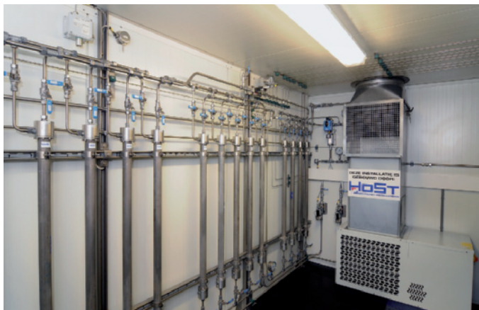
Gli impianti di upgrading a membrana sfruttano la diversa permeabilità del materiale con cui è realizzata la membrana ai diversi gas. Fonte: HoSt B.V.
