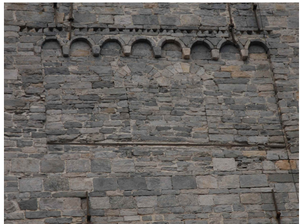
Santa Maria Maggiore, campanile, lato Est, piano terzo, bifora tamponata
