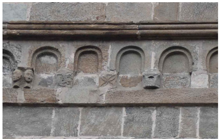
Santa Maria Maggiore, facciata, particolare della cornice ad archetti ciechi
