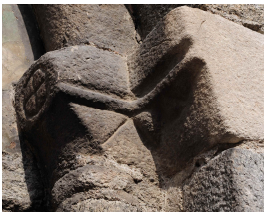
estS2c fianco Sud, portale d'ingresso, a destra capitello geometrico 24 x 50 x 32 calcare
