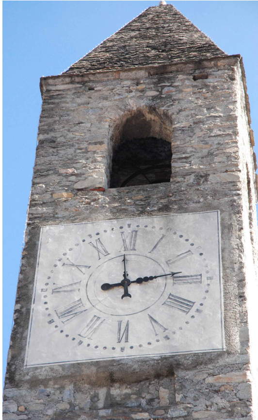
San Michele, campanile, lato Ovest, piano sesto e cella campanaria
