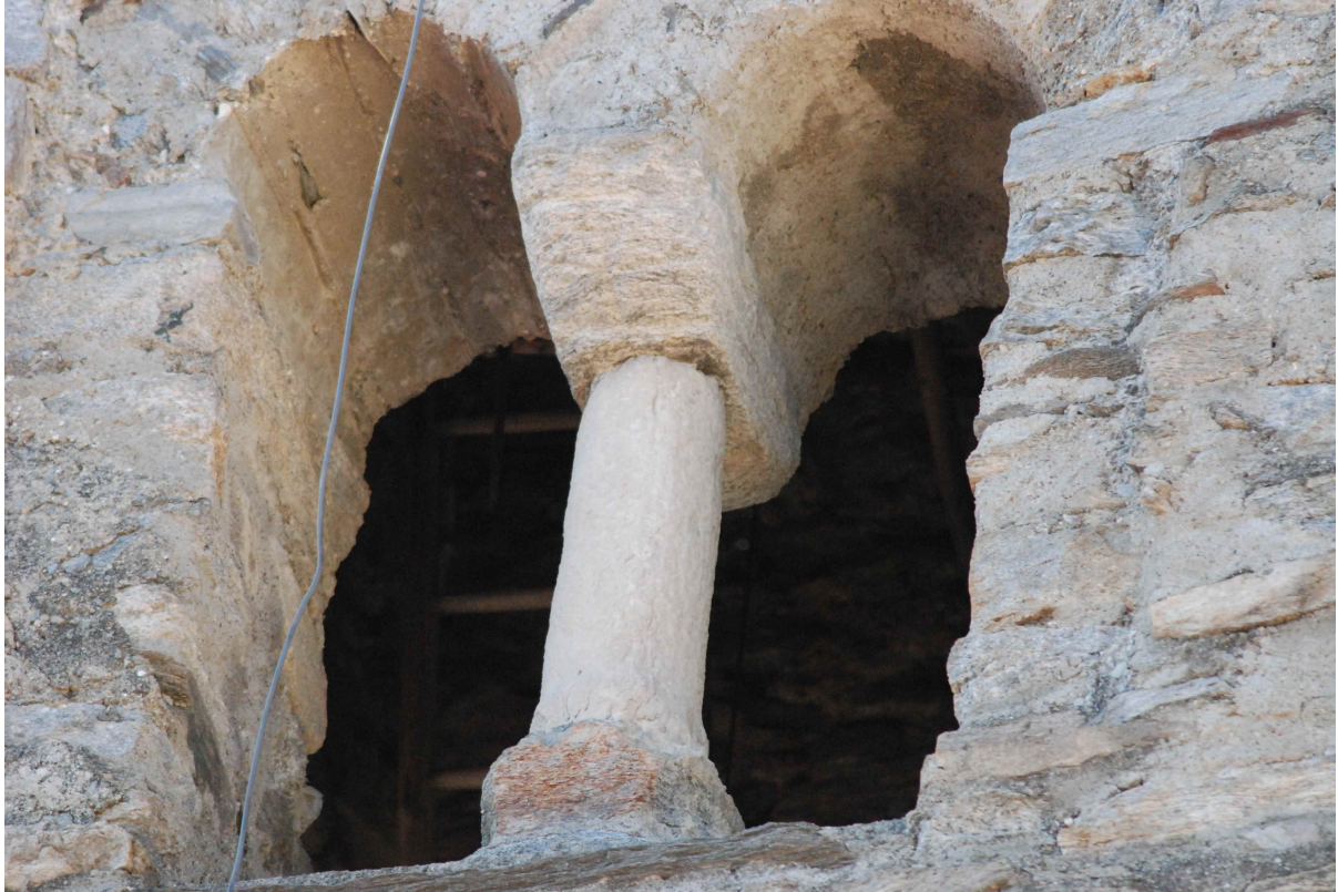
San Michele, campanile, lato Est, particolare della bifora
