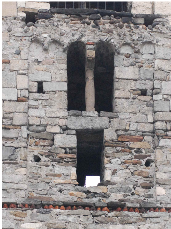
San Maurizio, campanile lato Sud, piano quarto, particolare
