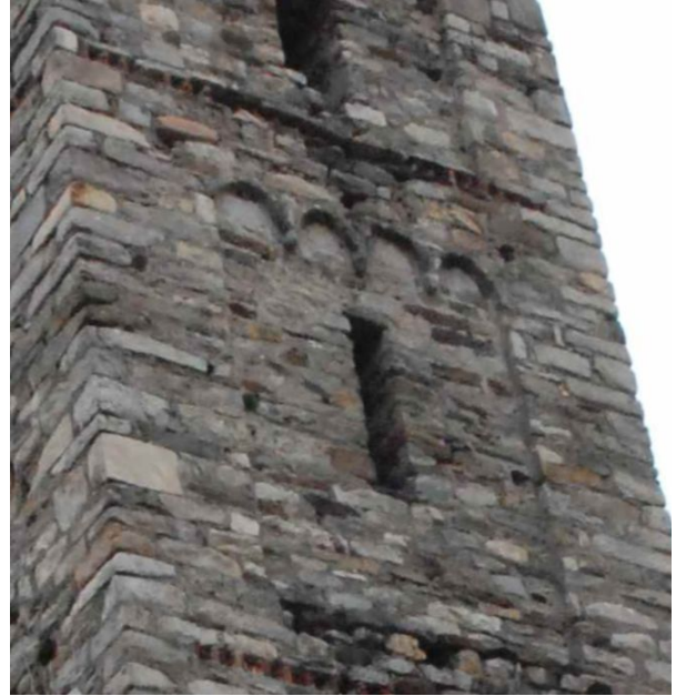
San Maurizio, campanile lato Ovest, piano terzo
