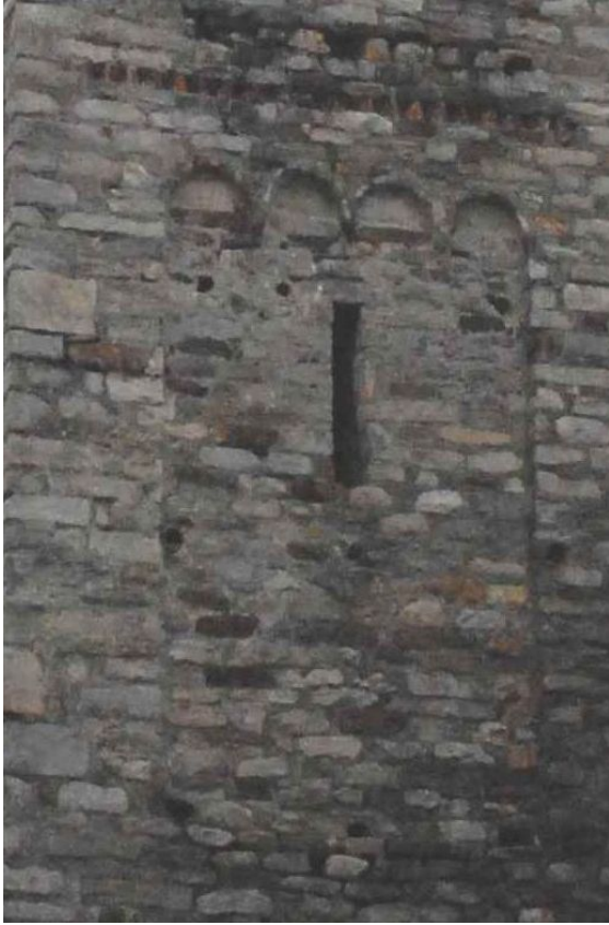
San Maurizio, campanile, lato Ovest, piano secondo
