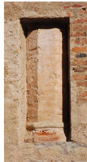
San Giuliano, fianco Sud, colonna di recupero
