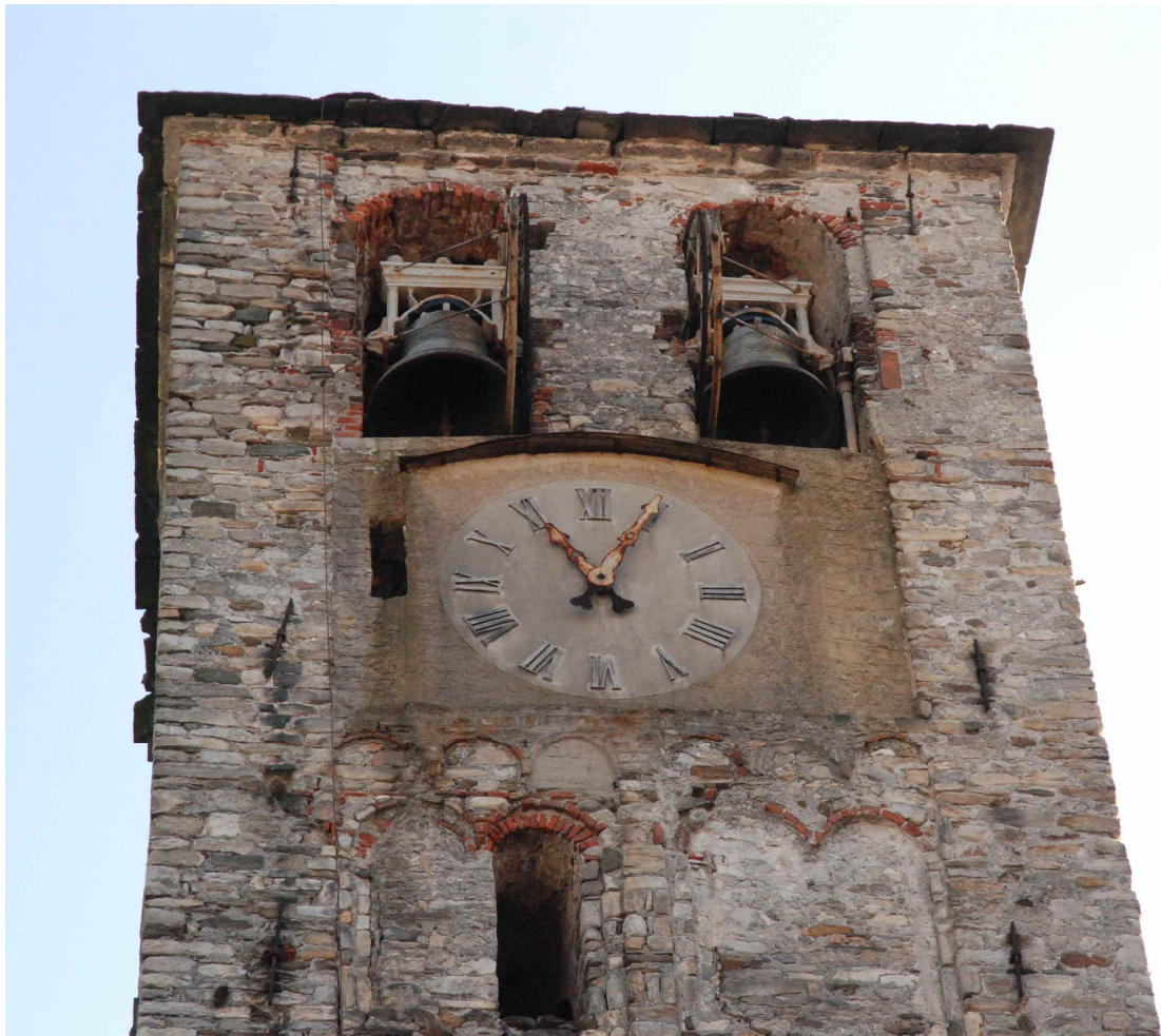
San Giuliano, campanile, lato ovest, cella campanaria
