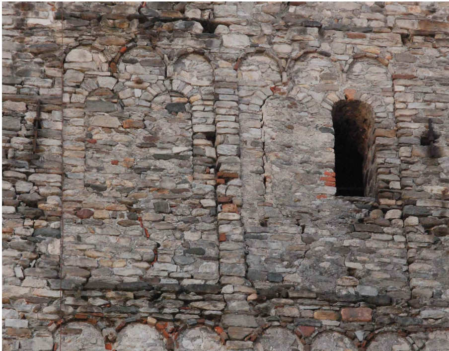
San Giuliano, campanile, lato Ovest, piano quinto, particolare
