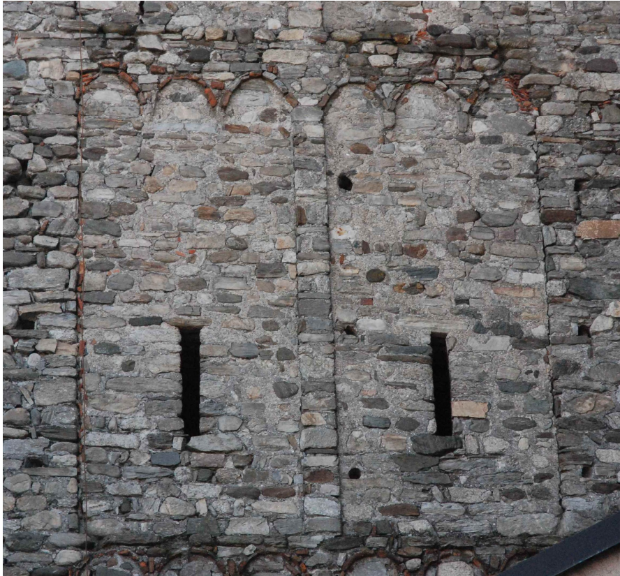
San Giuliano, campanile, lato Ovest, piano terzo, particolare
