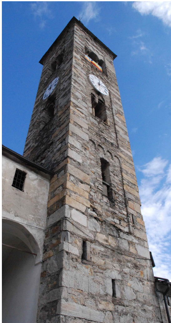
San Clemente, campanile, lato Sud-Ovest
