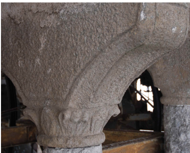
camN7cs lato Nord, piano quarto, trifora capitello a stampella fogliato 52 x 20 granito
