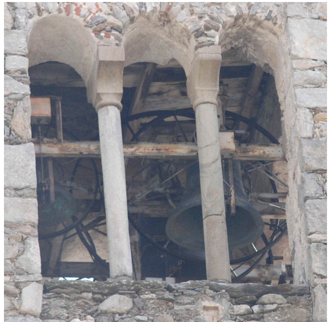
San Clemente, campanile, lato Ovest, trifora
