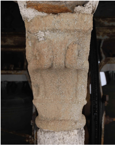
camS4cs lato Sud, piano quarto, trifora capitello a stampella geometrico 50 x 22 granito
