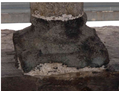
cam8b piani terzo e quarto, bifore e trifore (10) base a unghioni 20 ca x 15 ca granito
