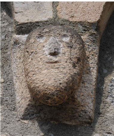
estS4p fianco Sud, campata terza, sottogronda, in prossimità dell'abside peduccio antropomorfo 15 ca. x 30 ca. granito
