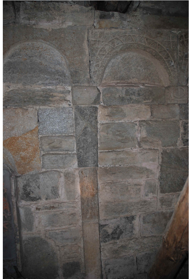
Santa Maria, sottotetto settentrionale, partizione muraria
