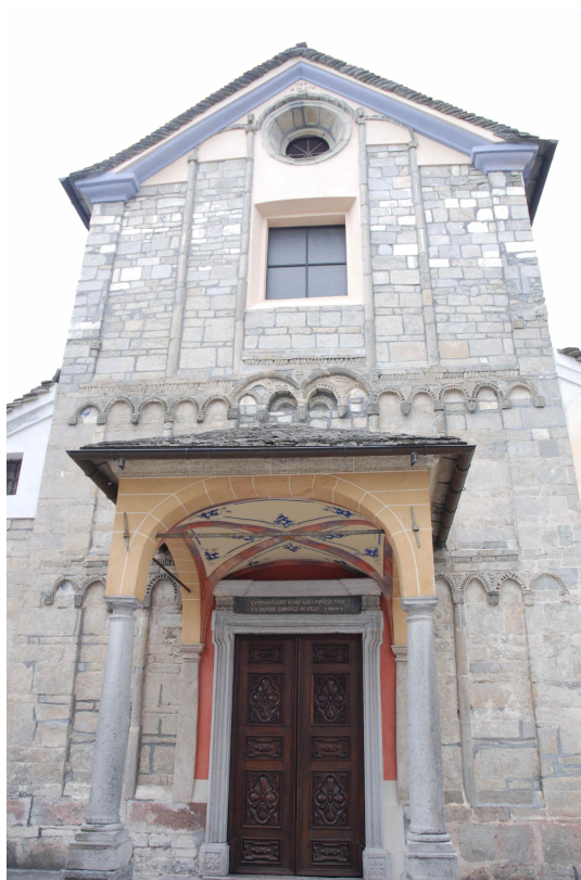
Santa Maria, facciata, sezione centrale
