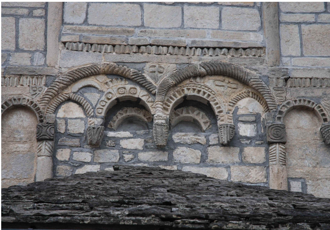
Santa Maria, facciata, cornice del secondo ordine, particolare
