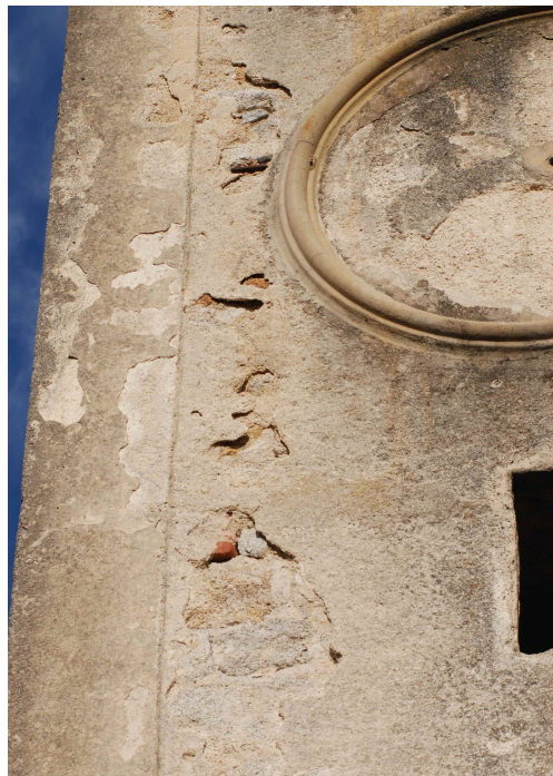
Sant'Anna, campanile, lato Est, particolare della muratura
