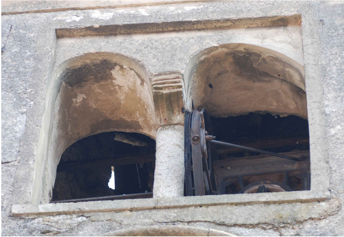
Sant'Anna, campanile, lato Sud, bifora
