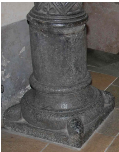
pul31b base posteriore a destra base a unghioni di restauro 45 x 40 x 40 marmo d'Oira
