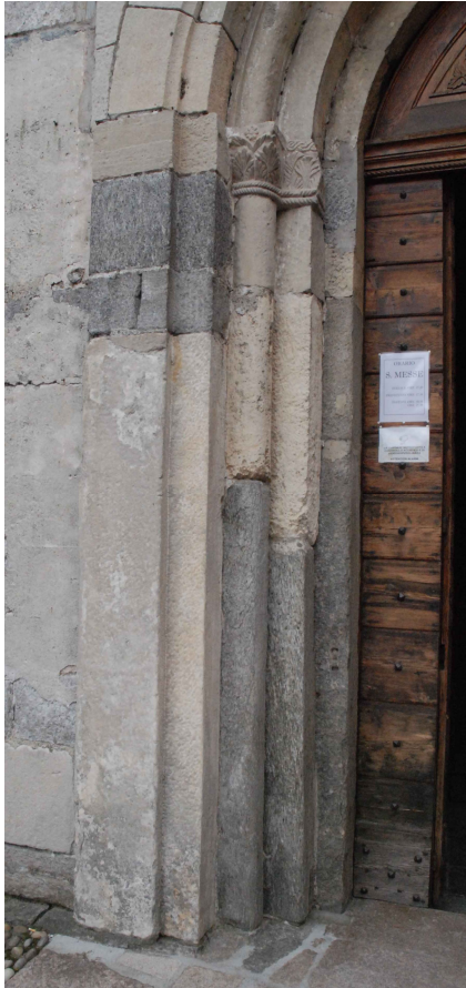
Santi Gervasio e Protasio, facciata, strombatura del portale a sinistra
