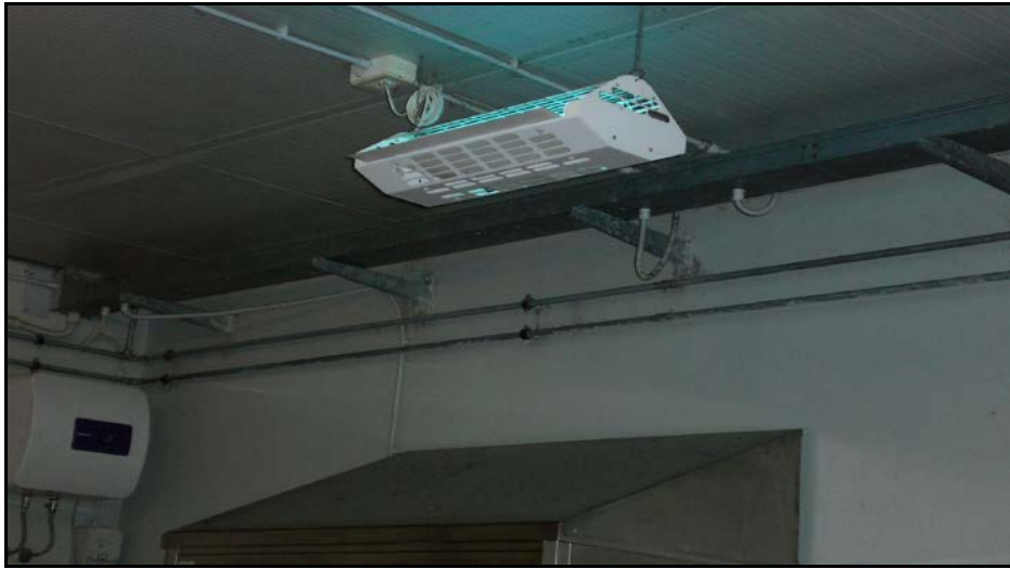
Fig.7.5. Particolare del plafone rivestito da pannelli termoisolanti con micronervature
