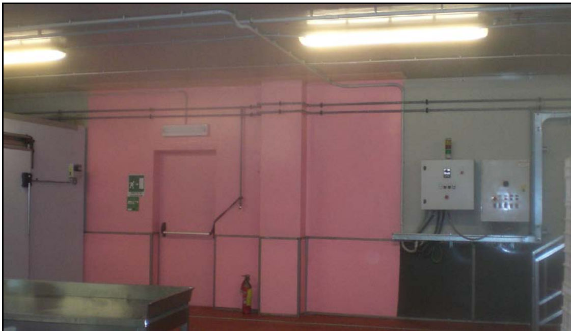
Fig. 7.12. Zona A di lavorazione del kiwi. Lo smalto rosa è stato applicato direttamente alla parete e lo zoccolo grigio ricoperto da pannelli in forex smaltati con la stessa tinta per creare una parete uniforme.
