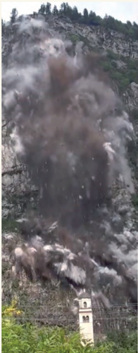
Immagine della frana del 29 maggio 2018.
