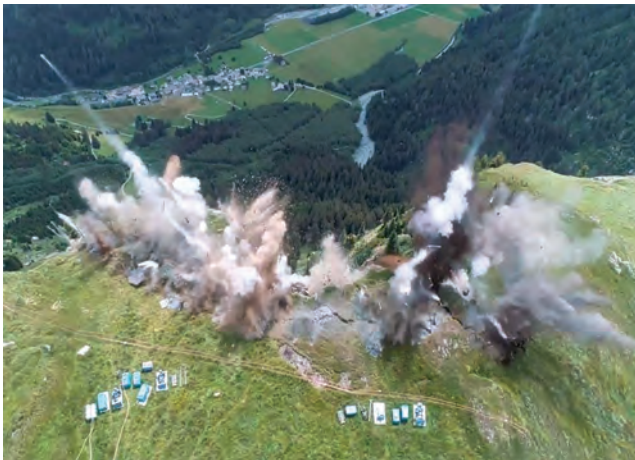
F.1.2: Brillamento artificiale della Frana di Boca Neira del 16 luglio 2020.
