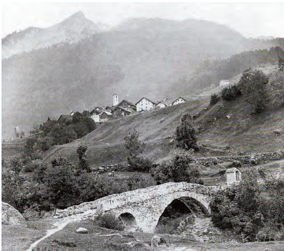
F.9.1: L'antico ponte di Cornone; sullo sfondo, il villaggio di Dalpe, in una copia di una fotografia del 1901 (autore sconosciuto).
