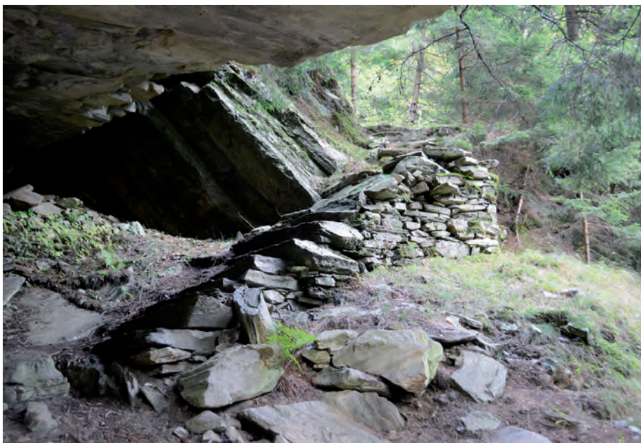
F.6.1: Scalinata in pietra che fuoriesce da un riparo sotto roccia lungo il sentiero Pighé - Mont de Rodot. ©Cristian Scapozza, IST-SUPSI.
