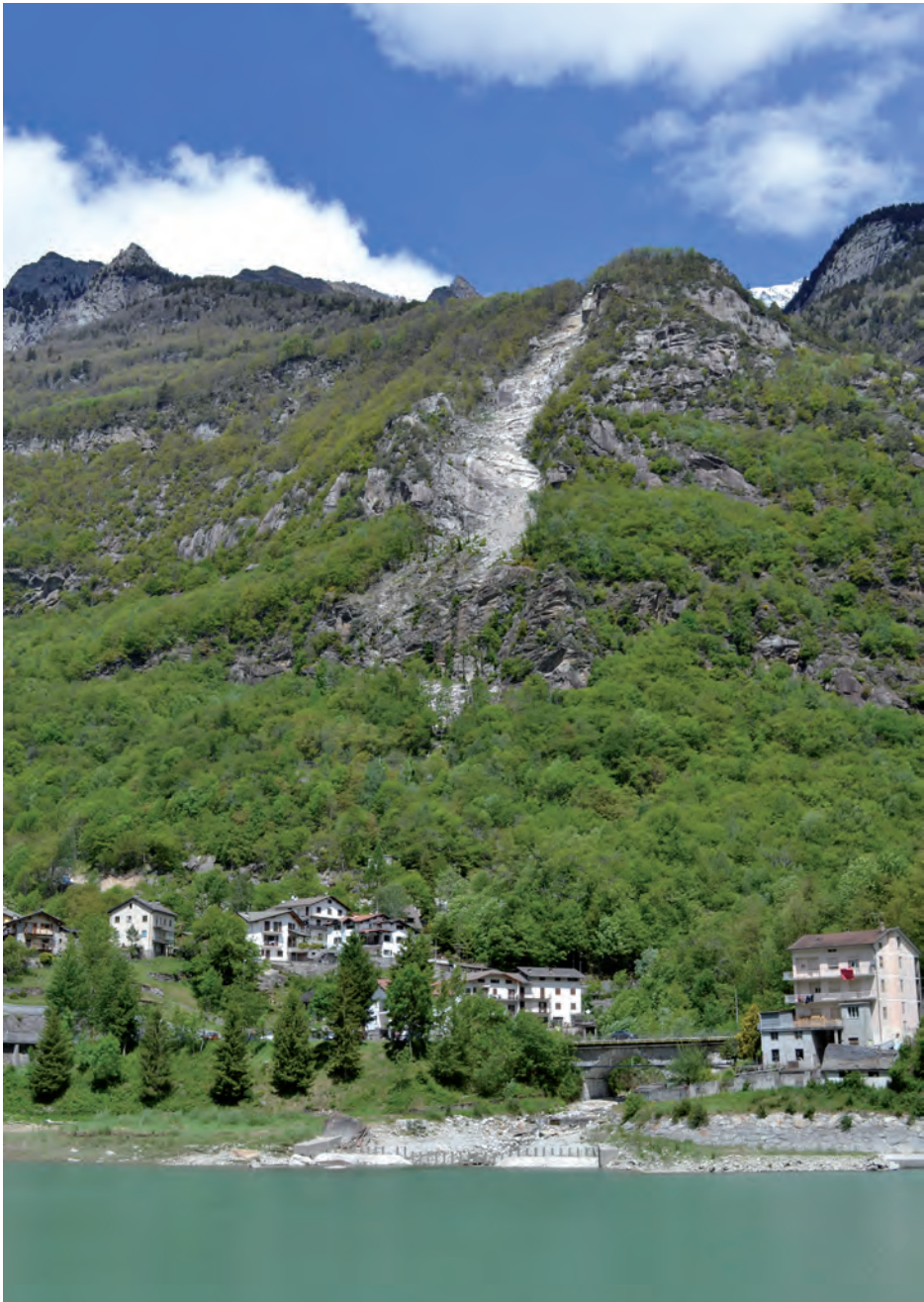
F.2.1: La frana di Motta di Calestro, vista dall'invaso artificiale di Villa di Chiavenna. ©Andrea Morcioni, UNIMI.
