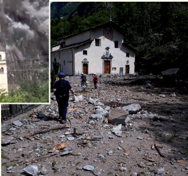
Piazzale del Santuario dopo il crollo. ©Luca Dei Cas, ARPA Lombardia.
