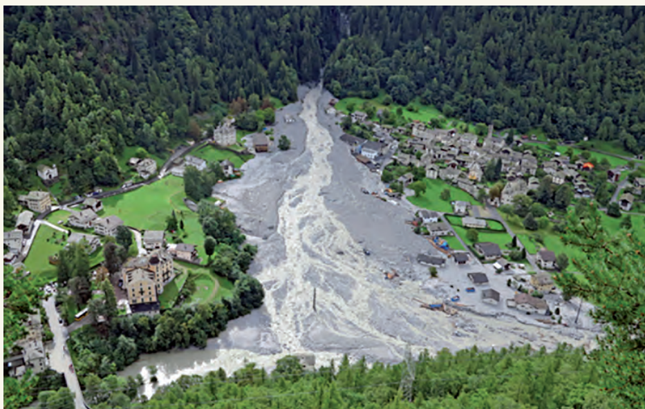
La devastazione di Bondo dopo la colata detritica nella notte del 1° settembre 2017. ©Marco Giacometti, www.centrogiacometti.ch
