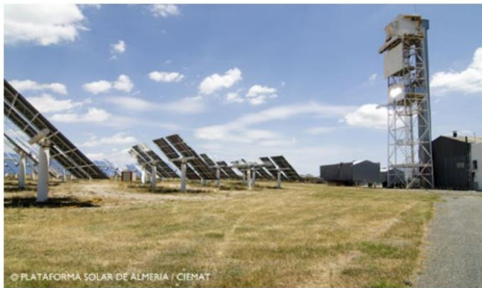
© PLATAFORMA SOLAR DE ALMERÍA / CIEMAT
