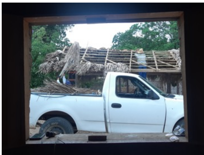
Figura 68 - Costruzione della pagoda. San Pablo Huitzo. Maggio 2021. Foto dell'autrice.
