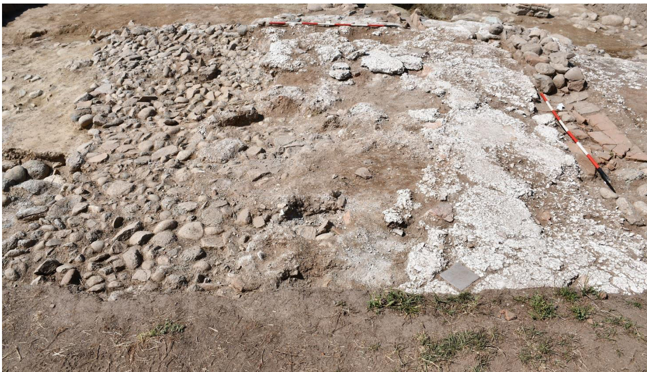
Fig. 17. Il pavimento in cementizio a base litica US 305 (foto da sud).
