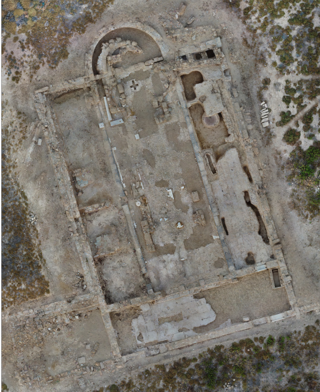
Fig. 2. Efestia. Area del porto orientale. Aerofotografia della basilica proto-bizantina e delle fasi preesistenti e successive (© Archivio fotografico SAIA U/11951. El. M. Pettrakis - C. De Domenico).
