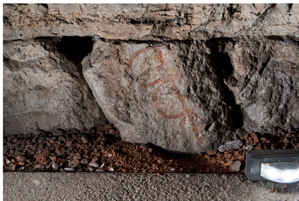
Fig. 17. Colosseo, galleria intermedia. Caduceo dipinto sulla parete nord.
