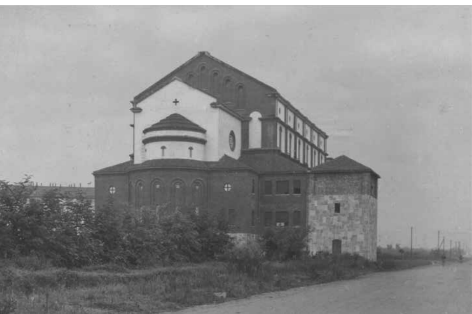
La vecchia chiesa sventrata e, sotto, il nuovo edificio appena terminato.
