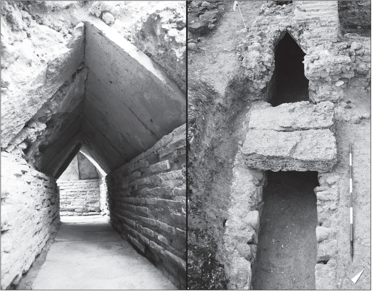
Fig. 5 - Nora, Area E, Terme Centrali. Le differenti tecniche edilizie del condotto fognario US 31029.
