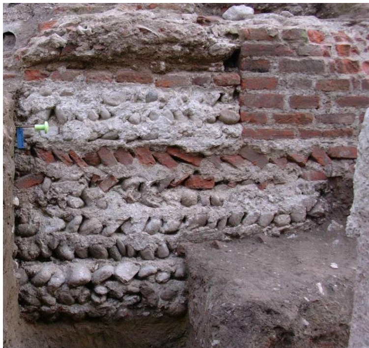
Fig. 7 - Tecnica di alzata ad opus spicatum (in ciottoli e laterizi) alternato a corsi di laterizi di piatto (A11).
