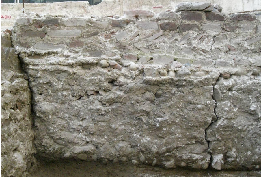
Fig. 6 - Tecnica di alzata ad opus spicatum (A9).
