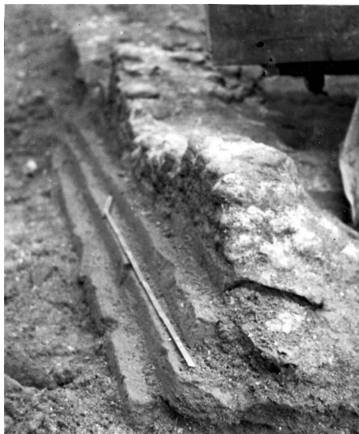
Fig. 1 - Tecnica di fondazione “a gradoni” (F6).
