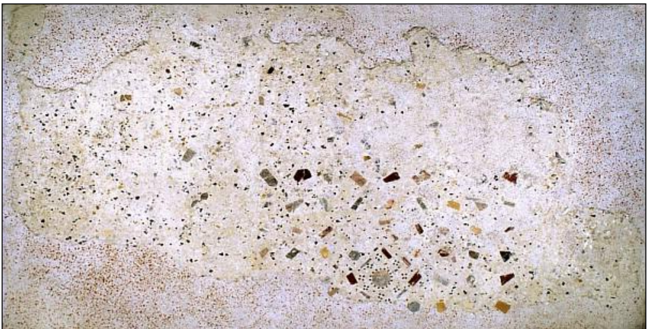
Fig. 1 - Ambiente 2, Fase III. Pavimento in cementizio dopo lo stacco e la musealizzazione (AF - DIGI027489).
