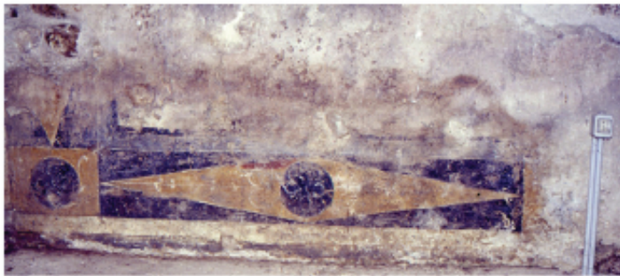
b. Montecorvino Rovella (Salerno), località Occhiano, Sant'Ambrogio. Perimetrale sud, resti di specchiature dipinte a sezioni geometrici.
