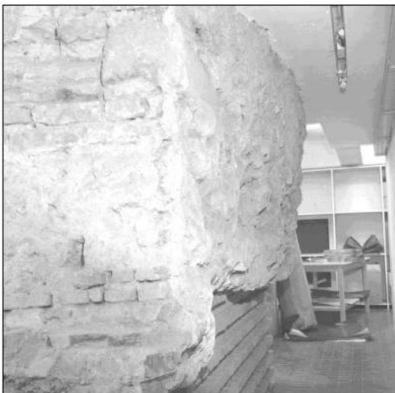
48. Via Montenapoleone 27, tratto della cortina (AFS A02859).
