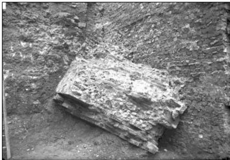
15. Tratto di mura rovesciate in via P. da Cannobio ( La veneranda anticaglia 1960, n. 1, AFS D750).
