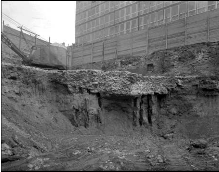
54. Corso Europa, Largo Corsia dei Servi, palificazioni sottostanti le Terme Erculee (AFS B330).
