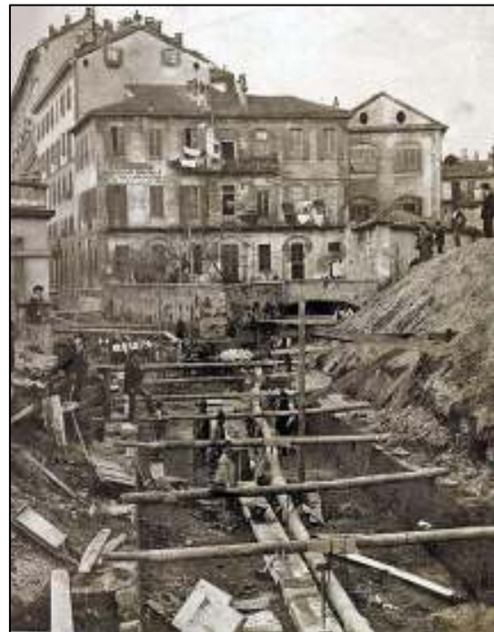
95. Cantieri di copertura della Vettabbia nel 1929.
