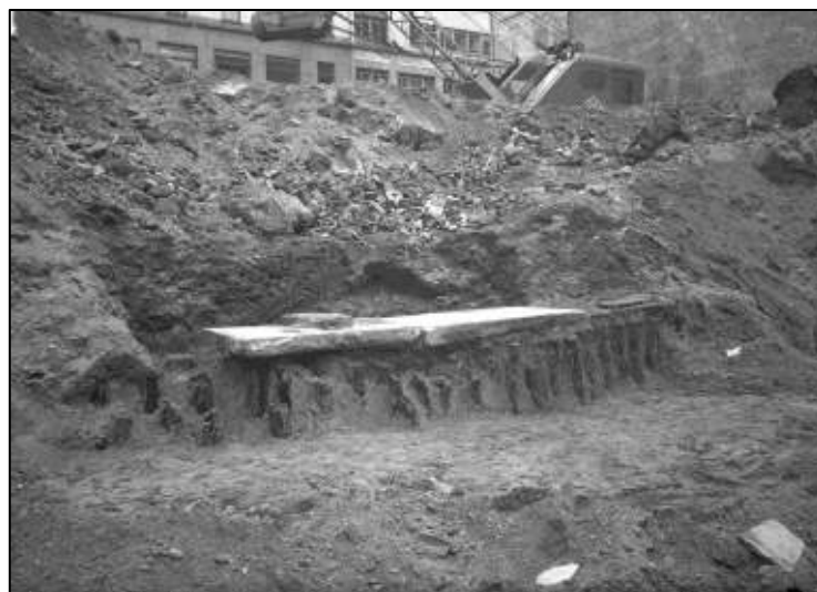
16. Banchina palificata in Via Baracchini ang. via P. da Cannobio (AFS D759).
