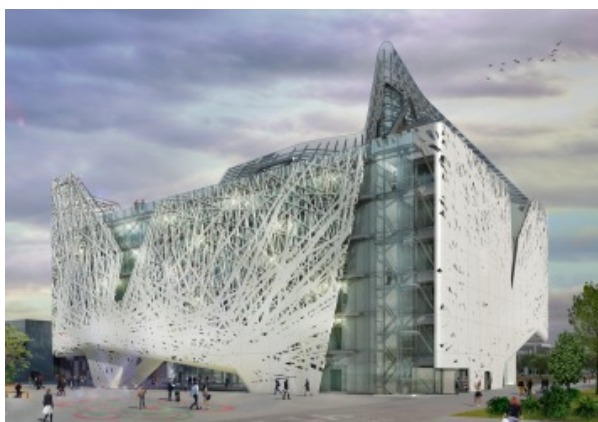
EXPO 2015 (Fig. 3), realizzato con cemento fotocatalitico (i.active BIODYNAMIC di Italcementi).
