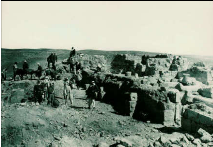
Fig. 5. Le operazioni di scavo nella basilica del Memoriale di Mosè, 1933 (© Archivio fotografico SBF, Gerusalemme).
