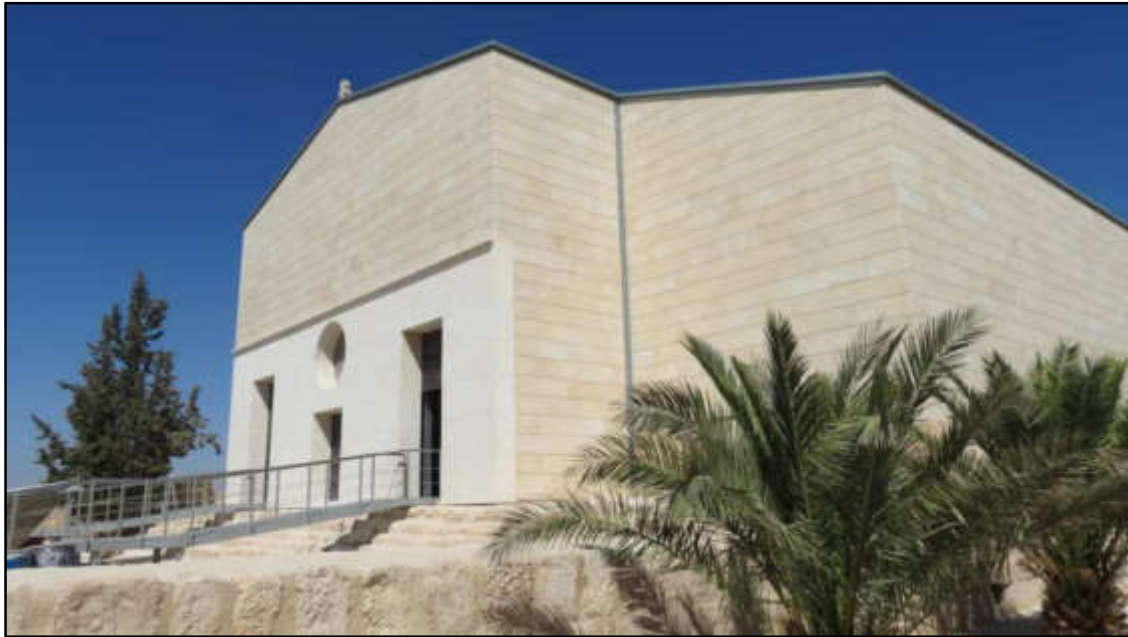
Fig. 9. Prospetto occidentale del Memoriale di Mosè dopo i restauri. Ottobre 2016. (© Archivio fotografico SBF, Gerusalemme).
