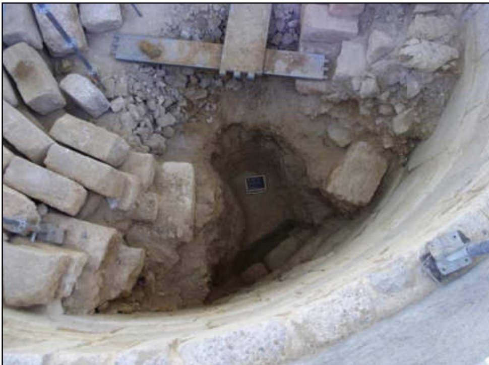
Fig. 15. Memoriale di Mosè. Presbiterio della basilica, demolizione del synthronon (foto dell'autore).
