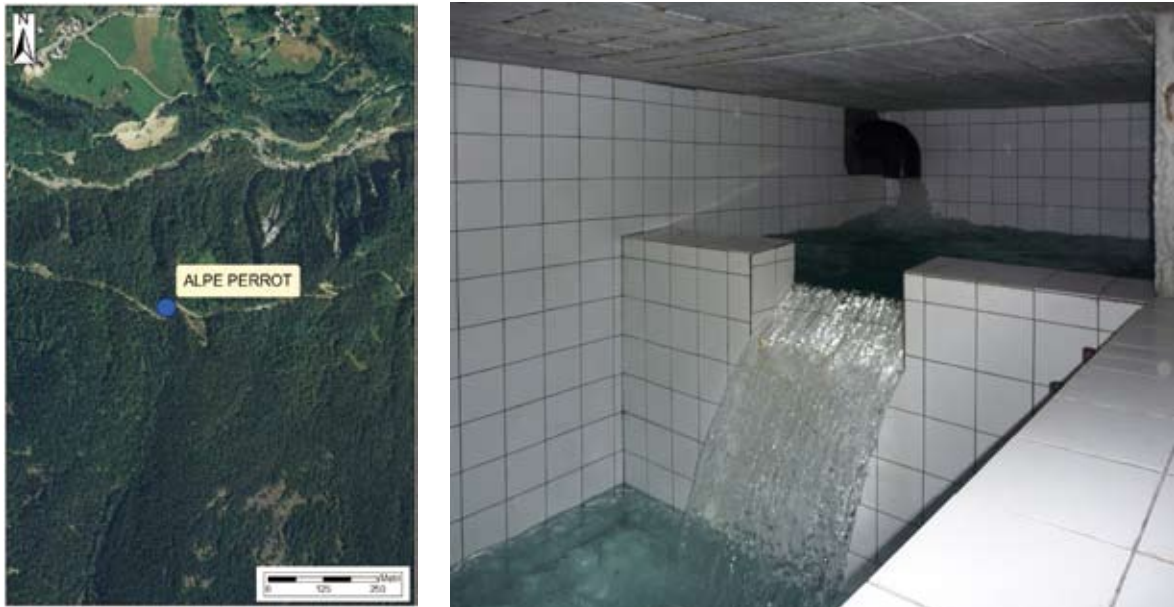
Fig.2: Ubicazione della sorgente denominata Alpe Perrot (a) e vasca interna con stramazzo (b).
