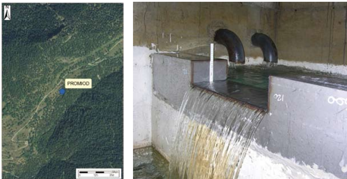
Fig.3: Ubicazione della sorgente denominata Promiod (a) e vasca interna con stramazzo (b).
