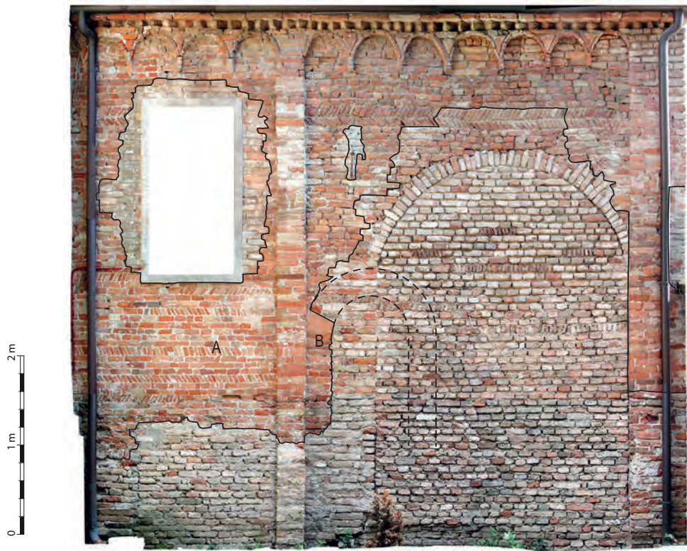
22. Perimetrale nord, presso la facciata. Fotoraddrizzamento e analisi, con individuazione della muratura (A) e della porta (B) di Fase I.
