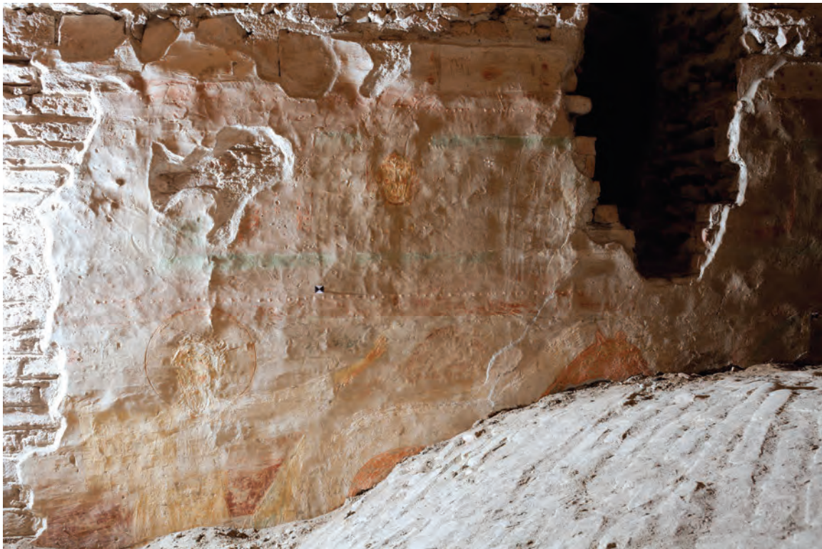
78-79. Incrocio, arco est, lato ovest (sottotetto), parte nord: l'Ascensione di Elia sul carro trainato da cavalli, sotto il meandro a svastiche includente sacerdoti del Tempio. L'illuminazione radente evidenzia l'irregolarità dell'intonaco e il rilievo delle stesure ricche di calce.
