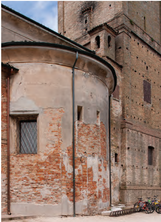
4. L'emiciclo absidale centrale. Nella parte bassa sono ancora intuibili le strette specchiature fra lesene di Fase I.
