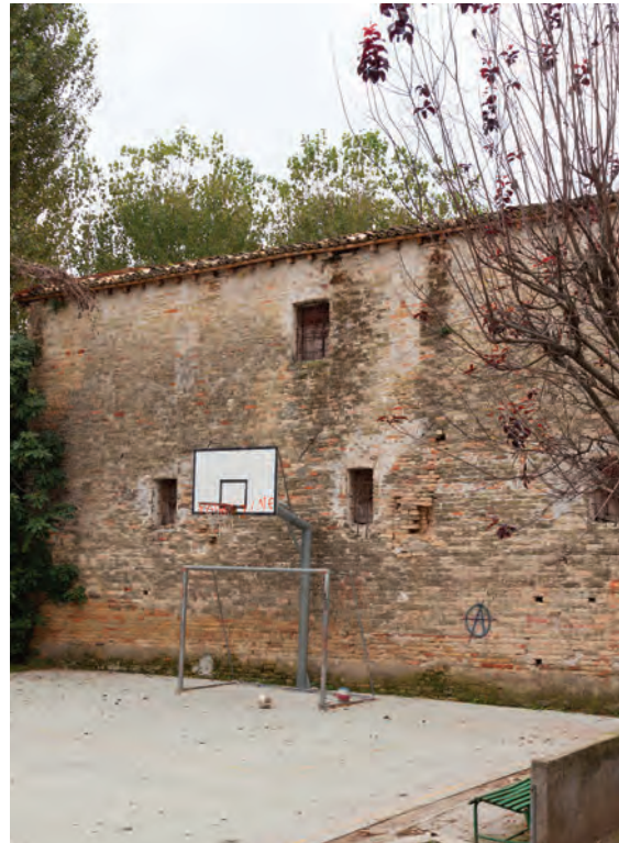
5. Prospetto orientale dell'edificio all'angolo nordest della planimetria di Tav. 1. I laterizi graffiati e le monofore (tampionate) suggeriscono una fase romanica matura, verosimilmente di XIII secolo.
