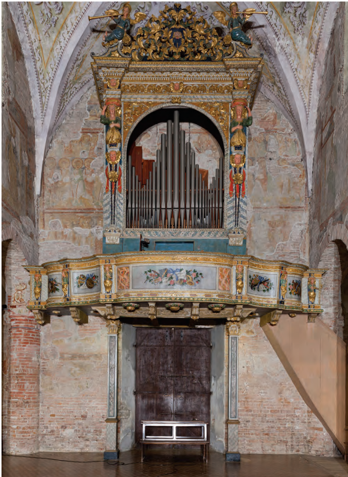
97. Controfacciata: il Giudizio finale, i cui resti sono in parte coperti dalla macchina dell'organo.
