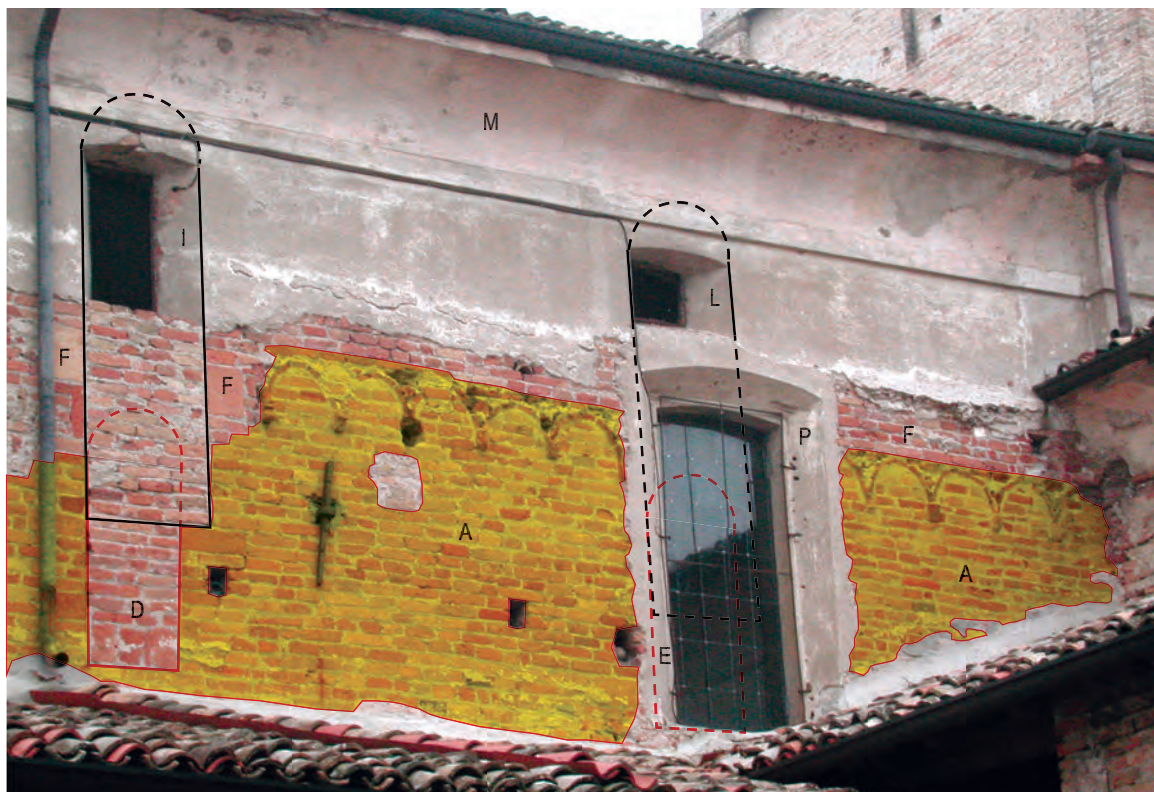
8-9. Cleristorio sud - Analisi stratigrafica, con individuazione della muratura con archetti della Fase I (lettera A), dei resti delle finestre (D, E). Nel corso della Fase III (lettera F), che innalzò la chiesa, furono chiuse le finestre precedenti e realizzate quelle nuove (I, L). L'assetto medievale fu poi quasi cancellato dalle grandi finestre barocche (O, P) e dalla cornice terminale (M).
