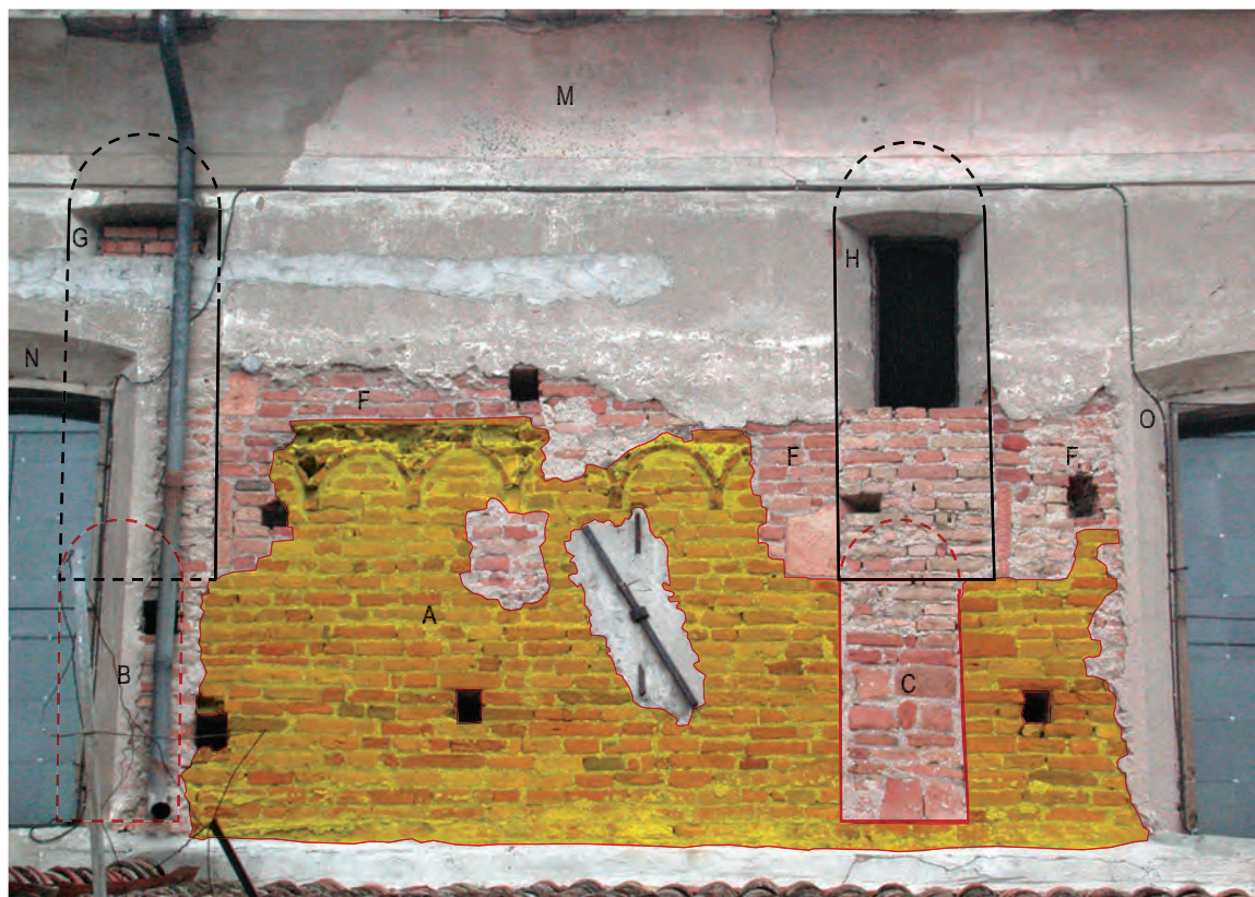
6-7. Cleristorio sud - Analisi stratigrafica, con individuazione della muratura con archetti della Fase I (lettera A), dei resti delle finestre (B, C). Nel corso della Fase III (lettera F), che innalzò la chiesa, furono chiuse le finestre precedenti e realizzate quelle nuove (G, H). L'assetto medievale fu poi quasi cancellato dalle grandi finestre barocche (N, O) e dalla cornice terminale (M).
