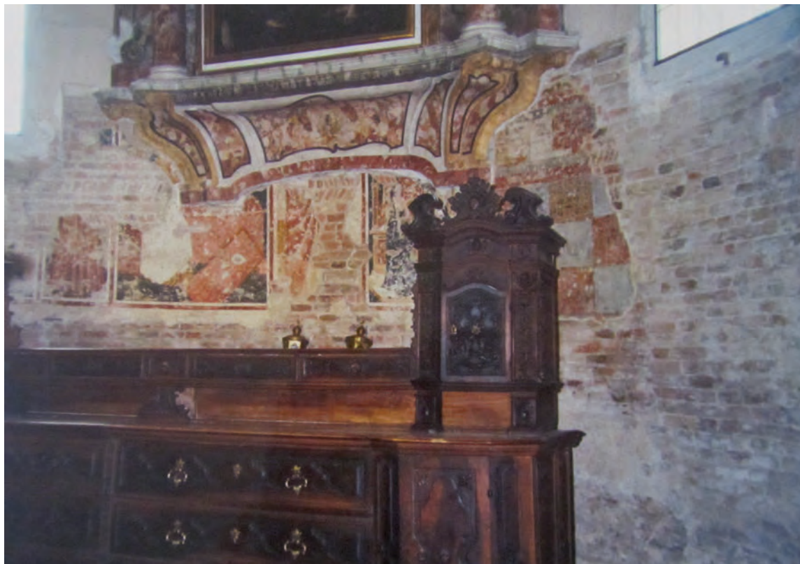
95. Lo zoccolo absidale dopo la completa rimozione dello scialbo (1990): accanto a riquadri tardogotici, sulla destra emerge un meandro che delimita specchiature dipinte a Scacchiera di triangoli a coda di rondine in quadrato.
