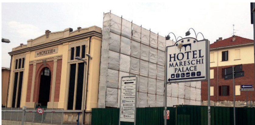
Figura 3. – Un'ala dell'ex cotonificio Wild in fase di ristrutturazione; i lavori per quanto riguarda il corpo principali sono invece già stati terminati (foto: Alessandro Santini, 2013).
