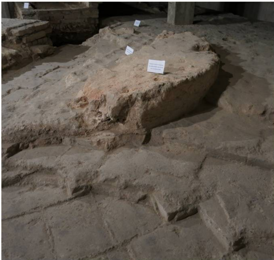
Fig. 13. Milano, Mausoleo, dettaglio della platea di fondazione in laterizi.
