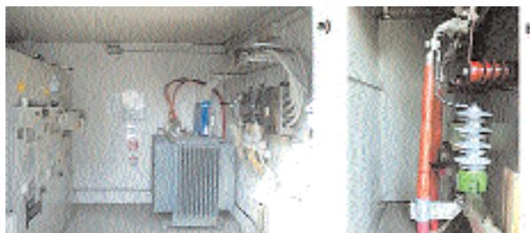
Figura 2 – Esempio di sottostazione secondaria coinvolta nella sperimentazione (a) e accoppiatore di media tensione utilizzato per permettere la comunicazione power line (b)
