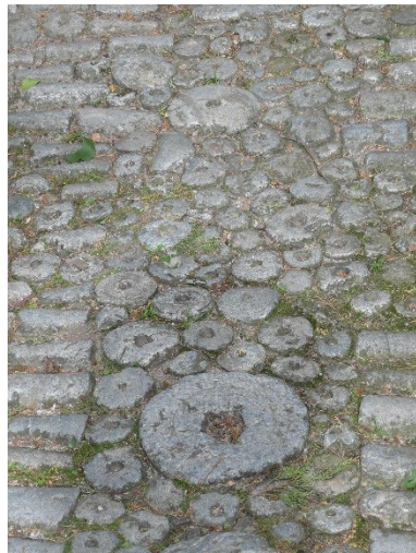
10 I bottoni derivati dalla lavorazione dei lavaggi e utilizzati per la pavimentazione. (Elisa Furlan Ph)
