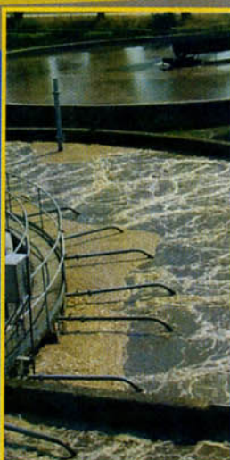
IMPIANTI ABBATTIMENTO AZOTO SISTEMA SBR DI DIGESTATO
