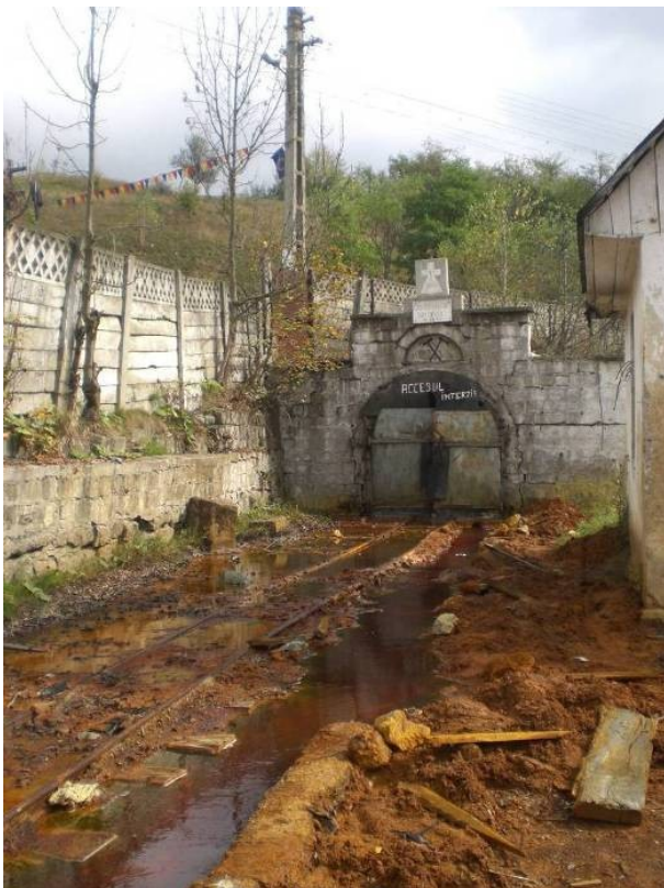
Fig. 4.4.: adit of the “Sf. Cruci din Orlea” gallery
