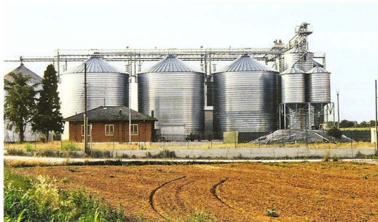
Impianto di conservazione della granella
