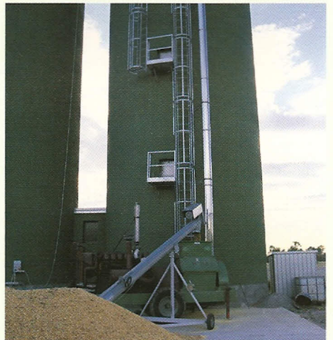
Sili ciclatori per la conservazione. Consentono il carico del prodotto dall'alto e lo scarico dal basso e permettono di ridurre le perdite di conservazione
