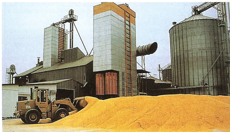
Moderno impianto di essiccazione della granella
