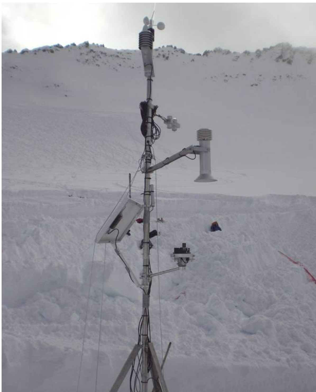
Fig. 10: Stazione meteorologica automatica (AWS) installata da PAT sulla superficie del Ghiacciaio Presena scattata a febbraio 2010 durante un'operazione di manutenzione. (Foto A. Senese)
