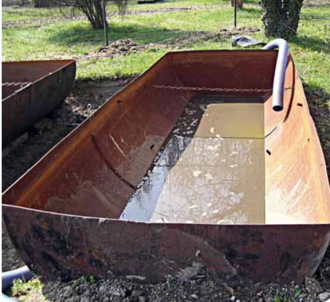
Particolare di una delle due vasche di raccolta dei digestati installati presso l'Azienda agroforestale Carpaneta di Bigarello (Mantova)
