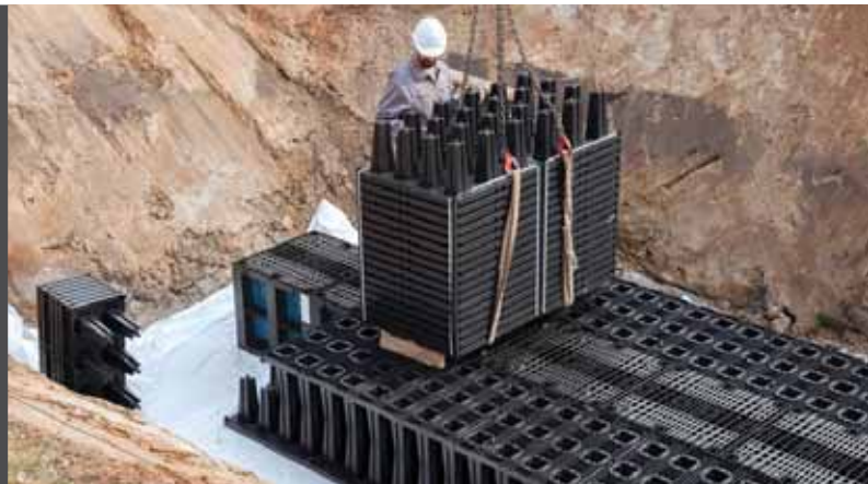
Fig. 1.10: installazione di sistemi geocellulari. Fonte: https://hydro-int.com/
