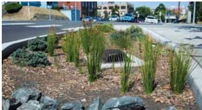
Fig. 2.12: troppopieno con griglia di protezione. Fonte: https://cob.org/
