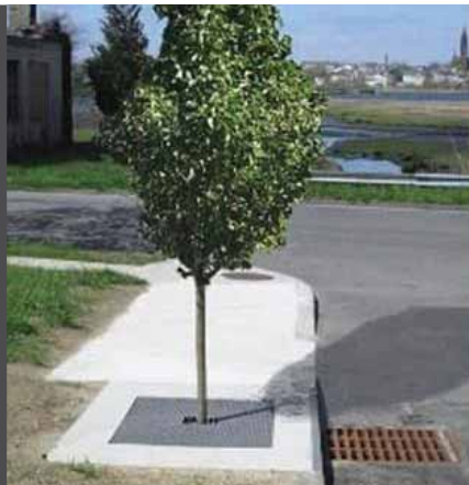
Fig. 3.4: tombino posto lateralmente al box filtrante e caditoia ricavata sul lato dello stesso. Fonte: www.ecolandscaping.org
