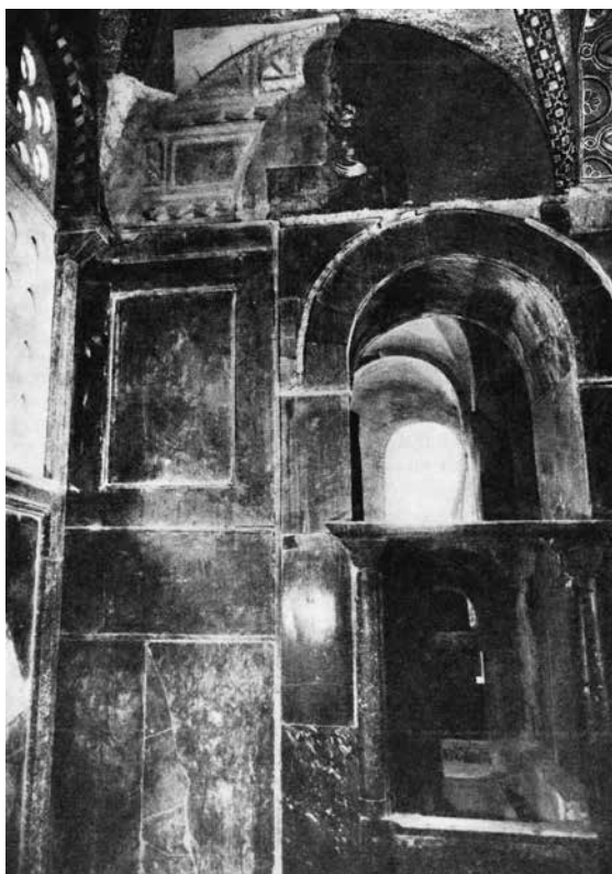
Fig. 2 – Monastero di Hosios Loukas, parete nord del katholikon , rivestimenti marmorei prima dello svelamento dell'affresco di Giosuè (da Stikas 1970).
