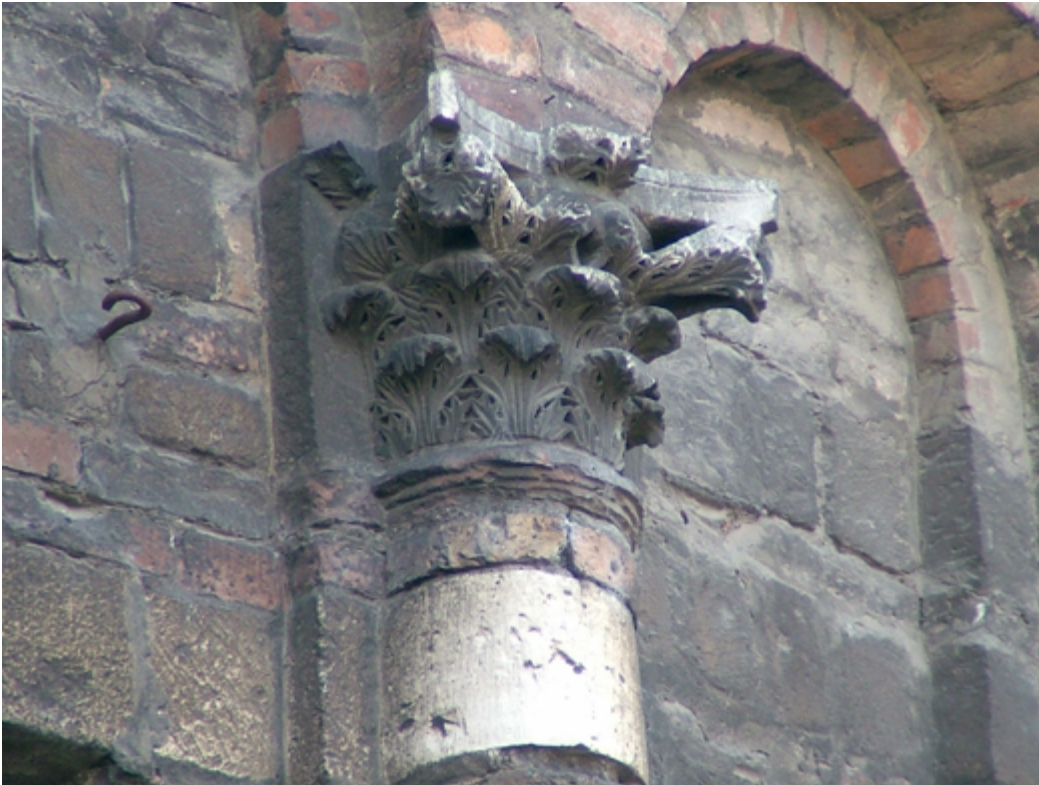
14 Verona, San Fermo maggiore. Prospetto orientale: capitello corinzio all'esterno del catino minore nord (F. Coden)
