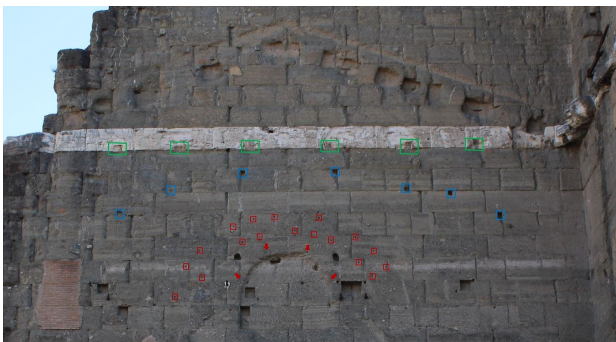
Fig. II.116 Muro di testata del portico sud. In evidenza le tracce degli incassi dei travicelli (in verde), dei fori per i perni lignei (in blu), dei fori per grappa per la serliana e dell'impronta della lunetta (in rosso).
