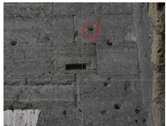
Fig. II.24 Muro di testata del portico, segmento tra la piattabanda di destra e lo spigolo del muro. In evidenza un foro allineato alla quota dei precedenti
