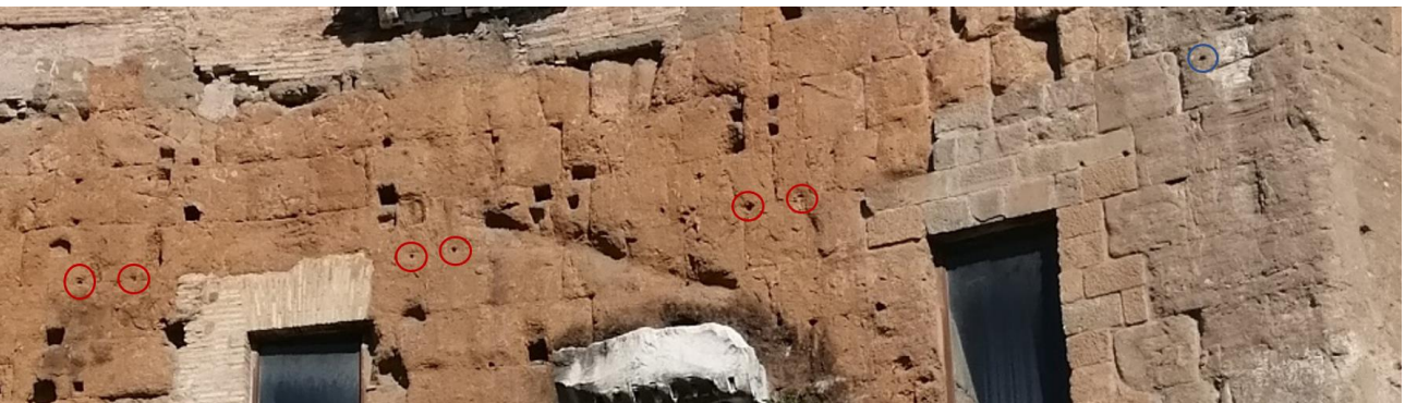
Fig. II.80 Esedra nord. In evidenza i fori del secondo gruppo riconducibili al fissaggio dei piedistalli (in rosso) e delle basi (in blu)
