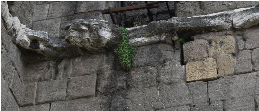
Fig. II.109 Muro di fondo del portico sud. In evidenza i resti della grondaia e della tamponatura in blocchi di tufo di Grotta Oscura
