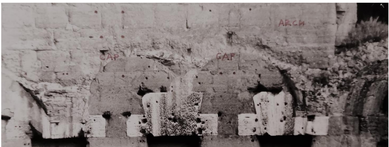
Fig. II.31 Foto di archivio di Bauer dell'esedra sud. In evidenza i fori per le grappe evidenziati dall'Autore
