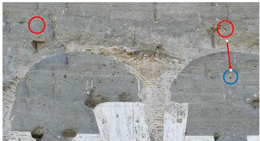
Fig. II.30 Muro dell'esedra, segmento tra la terza e la quinta piattabanda. In evidenza i fori per le grappe attribuibili ai capitelli (in rosso) e ai rocchi di sommoscapo (in blu)
