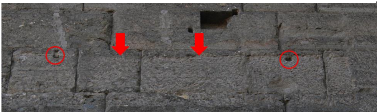
Fig. II.66 Muro di testata sud. In evidenza il segmento compreso tra la serliana e lo spigolo destro del muro, con i fori per grappa riferibili al fissaggio delle cornici e la porzione arretrata a subbia
