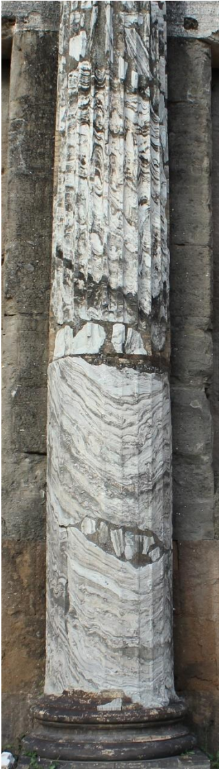
Fig. V.14 Elementi di fusto dei colonnati del primo ordine. Nel dettaglio: semicolonna in cipollino rimontata nel primo ordine interno dell'esedra nord; frammento di pilastro in cipollino del primo ordine delle esedre (FA 1); frammento in giallo antico verosimilmente di colonna del primo ordine libero del portico (FA 723)
