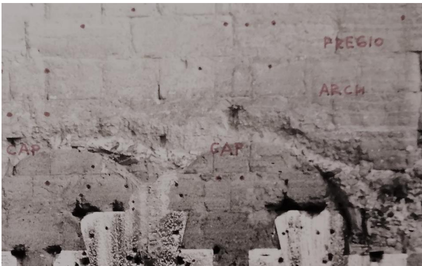
Fig. II.58 Foto di archivio del muro dell'esedra sud (Istituto Archeologico Germanico di Roma, NL Bauer 08). In evidenza i fori per grappa riferibili al fissaggio degli elementi dell'elevato evidenziati da Bauer
