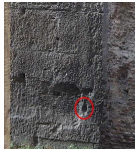
Fig. II.3 Muro di fondo del portico nord. In evidenza un eventuale foro per grappa riferibile ad una base di semicolonna
