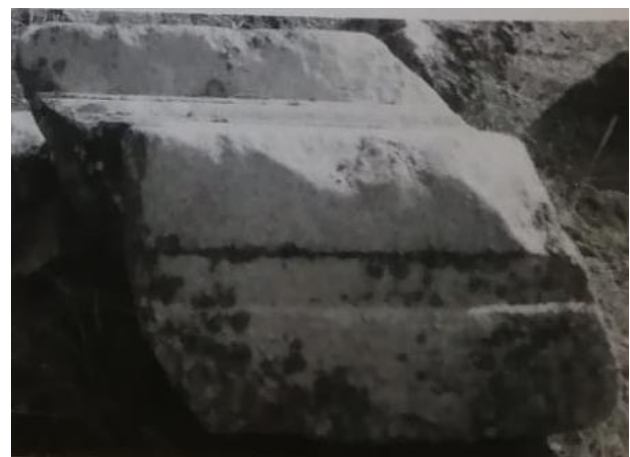
Fig. V.71 Santuario dei Grandi Dei di Samotracia, dettaglio dei cassettoni dello Hieron (da Tancke 1989)
