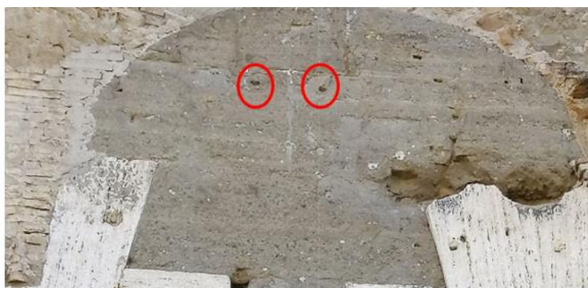
Fig. II.16 Muro dell'edera, segmento tra la terza e la quarta nicchia da sinistra. In evidenza i fori attribuibili al rocchio di sommoscapo
