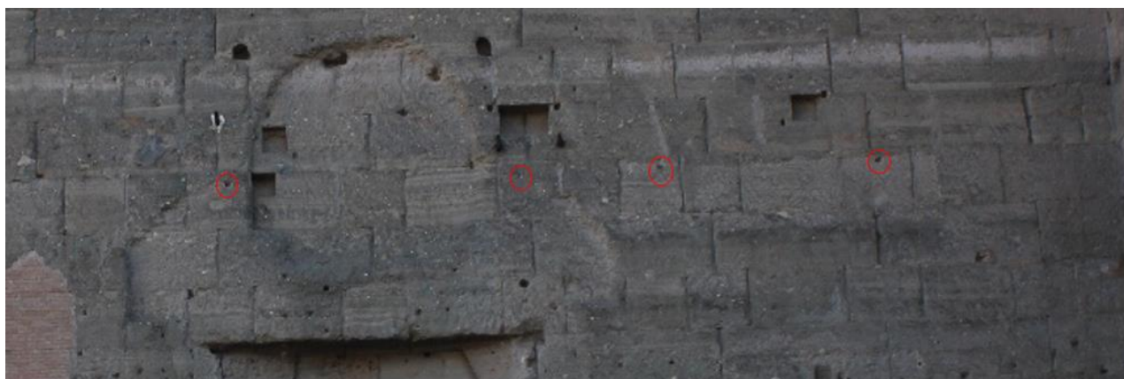
Fig. II.65 Muro di testata sud. In evidenza i fori per grappa riferibili al fissaggio delle cornici
