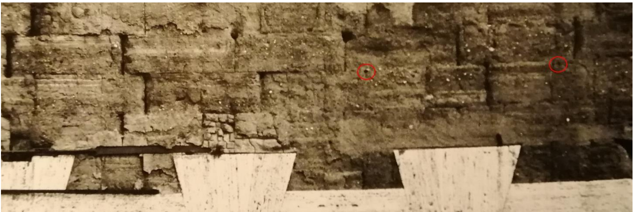
Fig. II.96 Foto di archivio di Bauer dell'edra sud. Segmento sommitale con in evidenza i fori per grappa attribuibili ai capitelli
