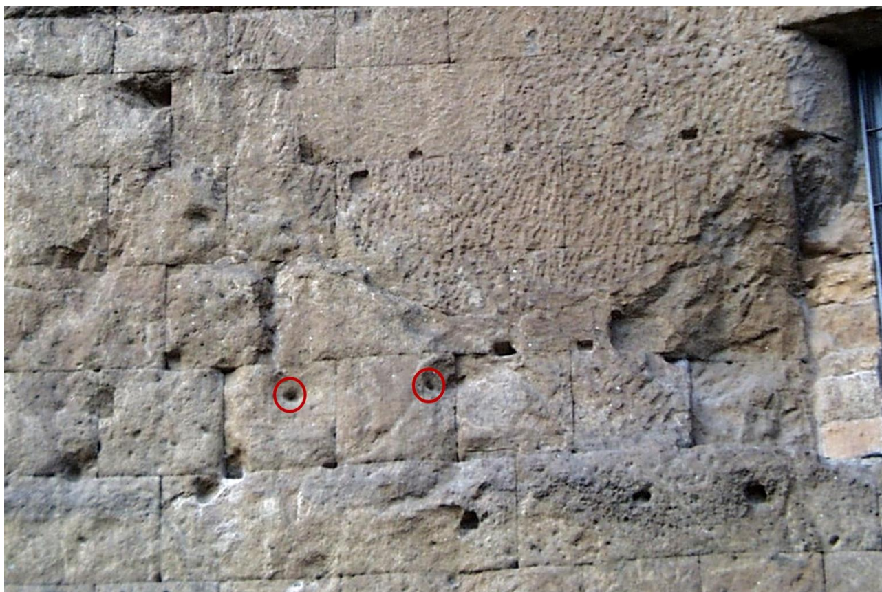
Fig. II.47 Esedra nord. In evidenza i due incavi conservati al di sopra della sesta piattabanda e riferibili al fissaggio degli architravi
