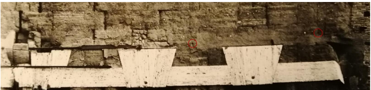
Fig. II.89 Foto di archivio di Bauer dell'esedra sud. In evidenza i fori per grappa riconducibili al fissaggio dei fusti
