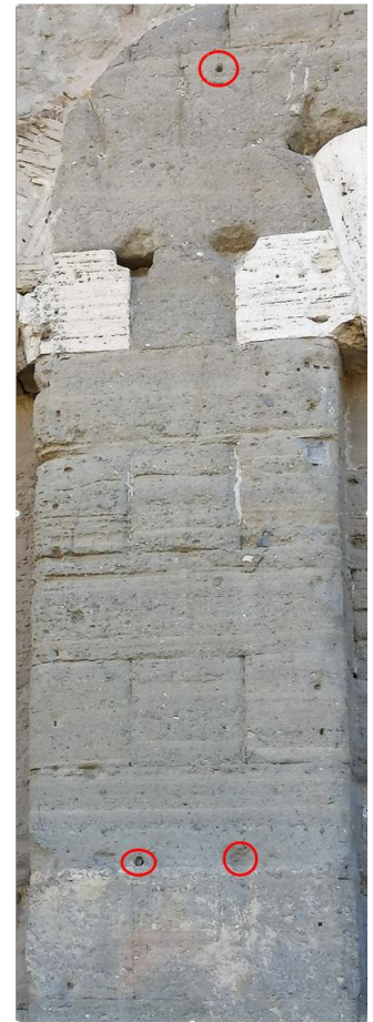
Fig. II.15 Muro dell'esedra, segmento tra la seconda e la terza nicchia da sinistra. In evidenza i fori attribuibili ai rocchi di sommoscapo e imoscapo
