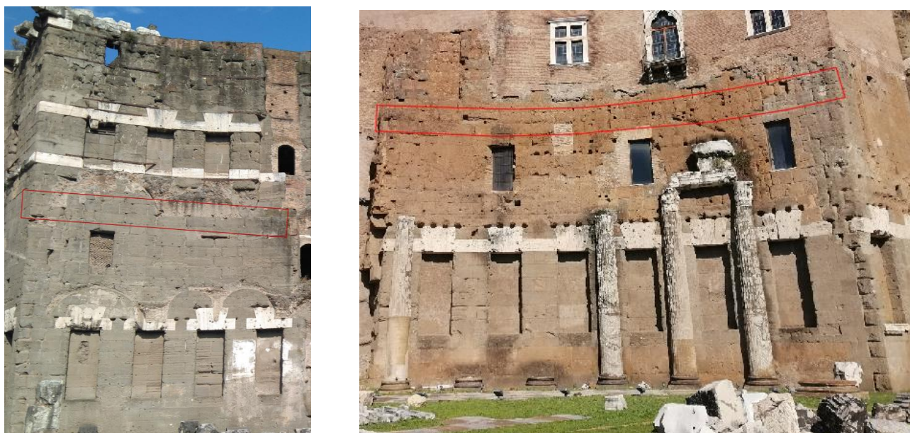
Figg. II.77a-b Emiciclo sud (a sinistra) e nord (a destra). In evidenza i filari riconducibili alla quota delle basi
