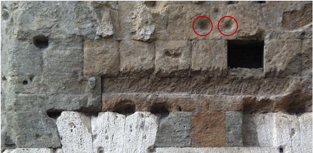
Fig. II.28 Muro di fondo del portico nord. In evidenza i due incavi riconducibili al fissaggio del capitello di semicolonna
