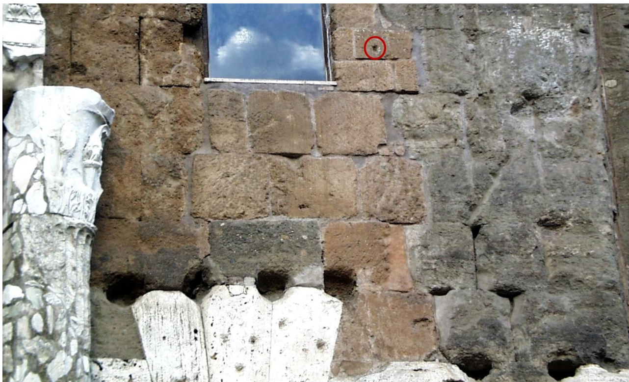
Fig. II.46 Esedra nord. In evidenza il foro per grappa conservato a ridosso dell'innesto del muro e riferibile al fissaggio degli architravi
