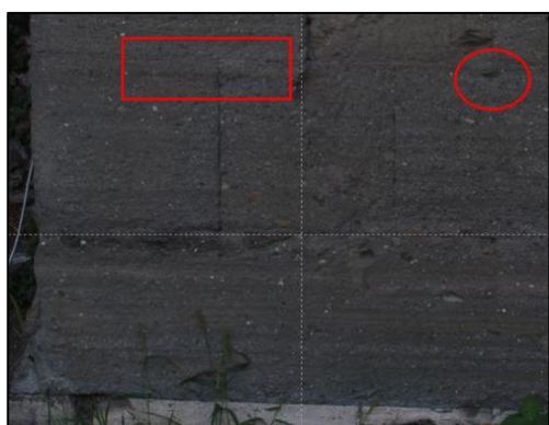
Fig. II.1 Muro di testata. Particolare delle tracce di risega e del foro attribuibili ad una base e ad una zoccolatura. A In posto. B Dal rilievo di Bauer.
