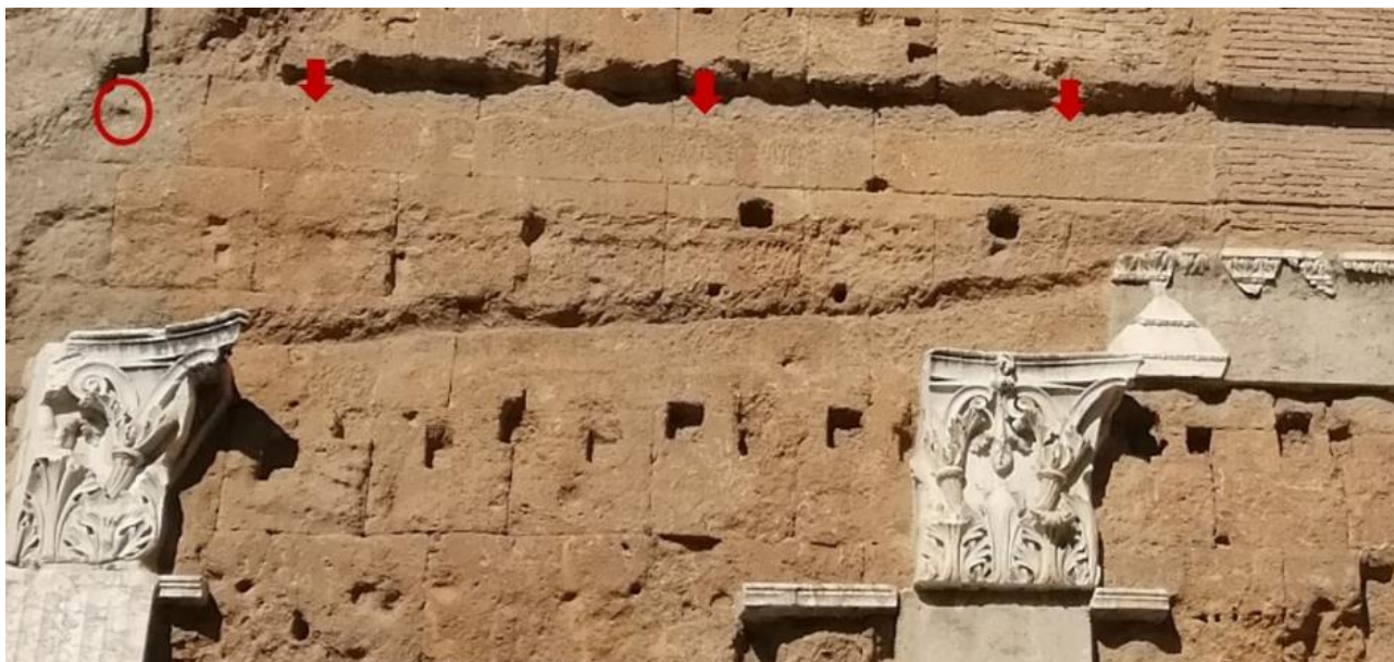
Fig. II.56 Aula del Colosso. In evidenza le tracce di lavorazione e le tracce di un incavo riferibili all'ancoraggio dei fregi
