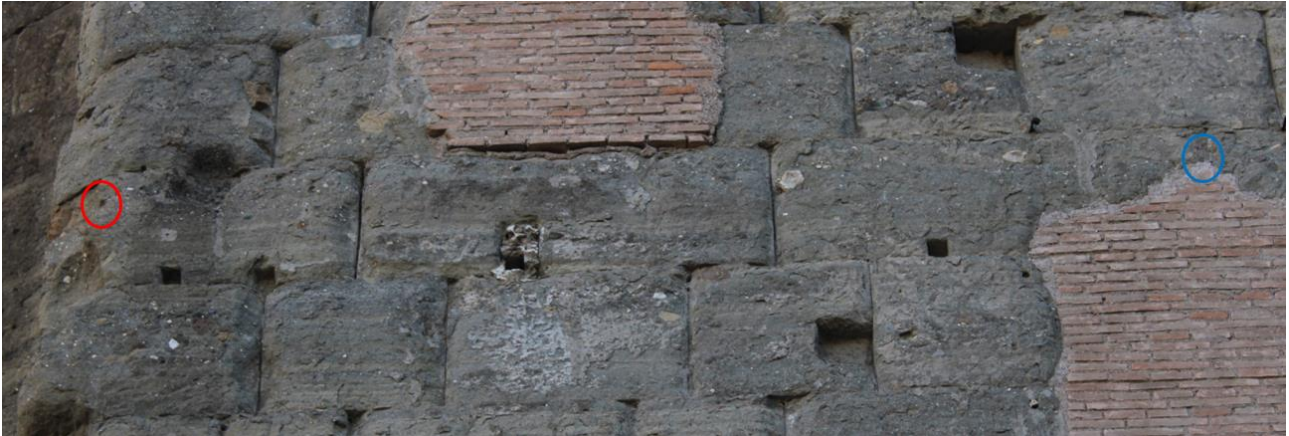
Fig. II.51 Muro di testata del portico sud. In evidenza il foro per grappa riferibile al fissaggio dell'elemento di fregio posto a ridosso dell'innesto del muro (in rosso), e il segmento entro il quale nelle foto di archivio è visibile un secondo incavo (in blu)
