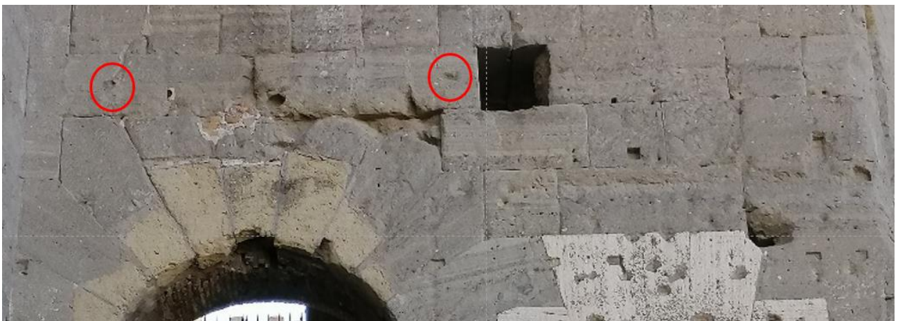
Fig. II.26 Muro di fondo del portico. In evidenza i fori per le grappe attribuibili ai capitelli
