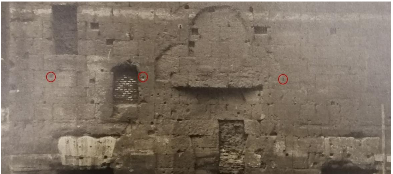
Fig. II.40 Foto di archivio del muro di testata del portico sud (N. Inv.) con i fori per grappa riferibili agli architravi in evidenza.
