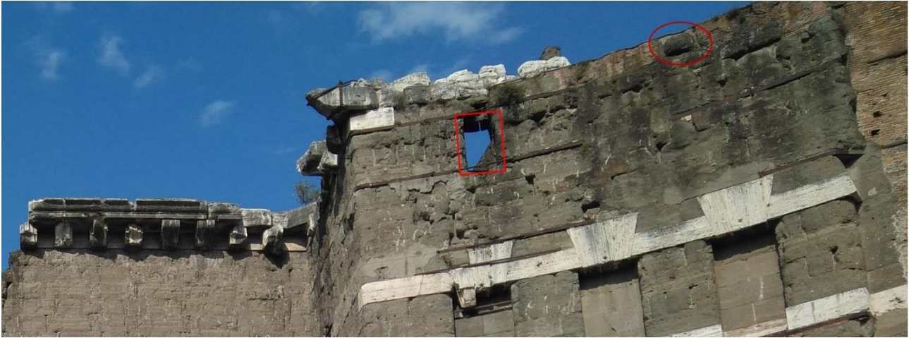
Fig. II.117 Estremità superiore del muro meridionale. In evidenza i resti della porta e di una eventuale mensola in tufo nell'esedra.
