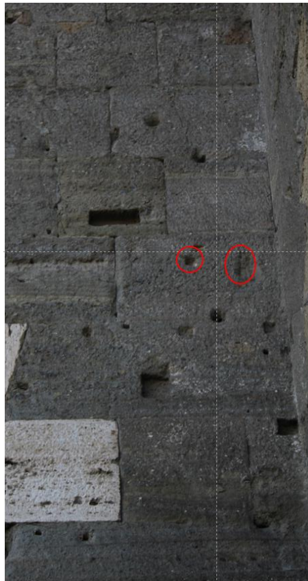
Fig. II.9 (a sinistra) Muro di testata, segmento tra la nicchia centrale e la nicchia di destra. In evidenza i fori attribuibili ai rocchi di sommoscapo e imoscapo.
