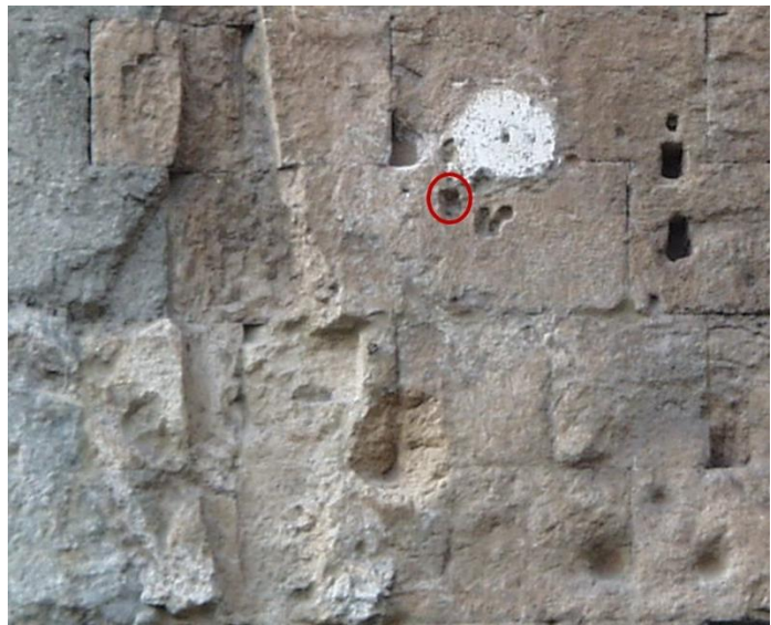
Fig. II.55 Muro di fondo del portico nord. In evidenza il foro per grappa ipoteticamente riferibile al fissaggio dei fregi
