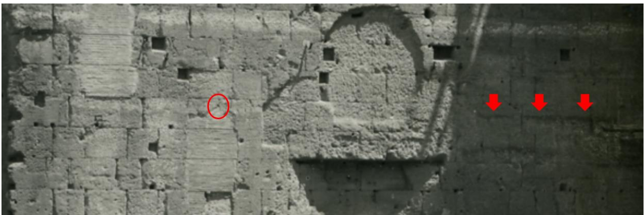
Fig. II.52 Foto di archivio del muro di testata del portico sud. In evidenza il foro per grappa riferibile al fissaggio dei fregi e la porzione di muro incassata
