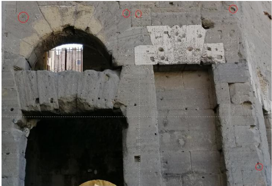
Fig. II.9 Parete di fondo del portico. In evidenza i fori collegabili con i fusti
