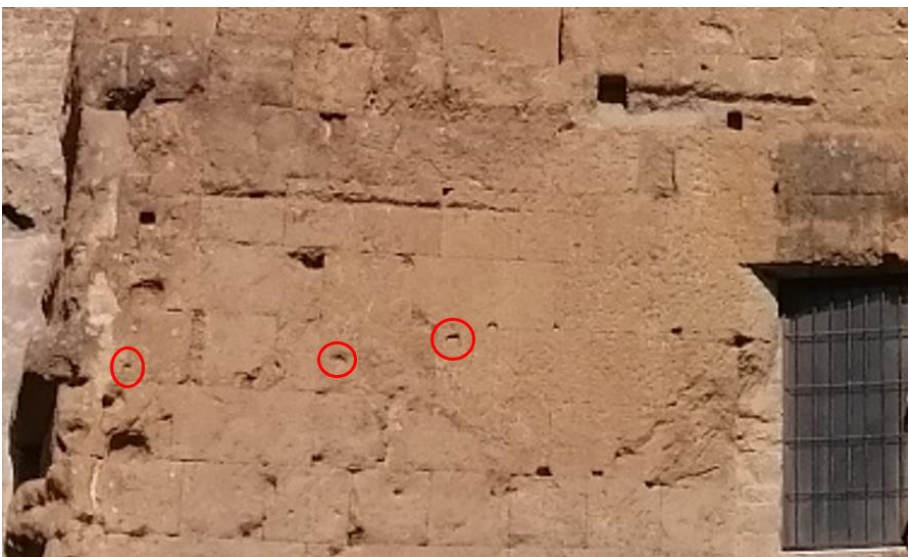
Fig. II.70 Muro dell'edra nord. In evidenza i fori conservati lungo la diciottesima assisa corrispondente al filare occupato dalle cornici
