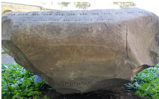
Fig. V.47 Foro di Augusto, architravi del primo ordine di fondo dei portici-esedre. In dettaglio il piano di posa (FA 659)
