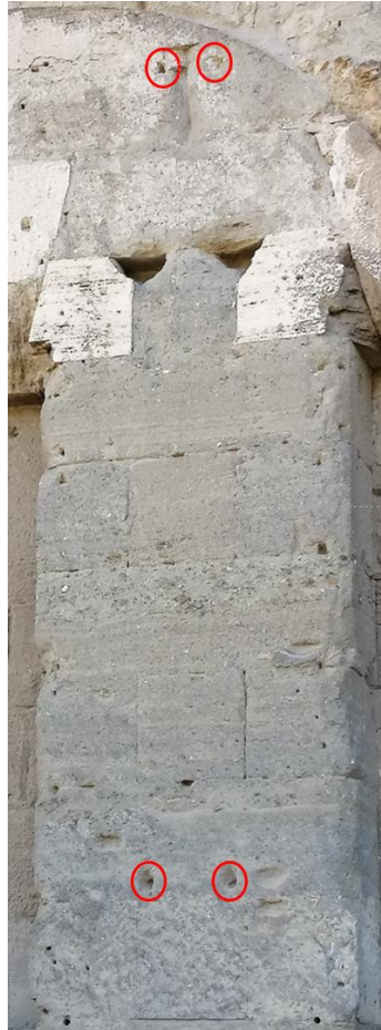
Fig. II.14 Muro dell'esedra, segmento tra la prima e la seconda nicchia da sinistra. In evidenza i fori attribuibili ai rocchi di sommoscapo e imoscapo
