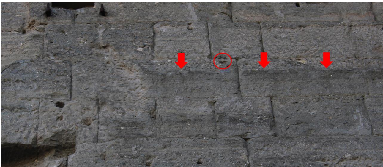
Fig. II.53 Muro di testata del portico sud. In evidenza la porzione di muro incassata e l'incavo posto lungo la sommità del filare
