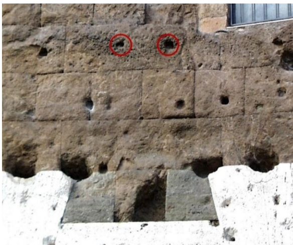
Fig. II.33 Muro dell'edra nord, segmento tra la terza e la quarta piattabanda. In evidenza i fori per grappa riconducibili ai capitelli
