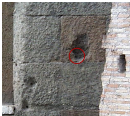
Fig. II.12 Portico nord. In evidenza l'incavo collegabile con un rocchio di imoscapo di semicolonna
