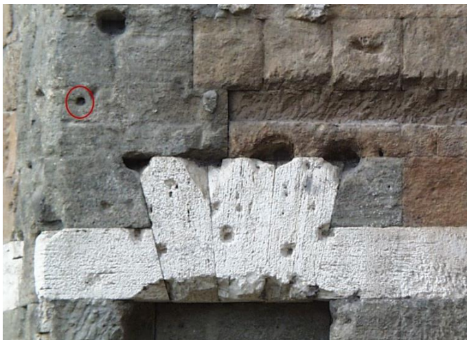
Fig. II.11 Portico nord. In evidenza l'incavo collegabile con il fusto di pilastro con semicolonna angolare
