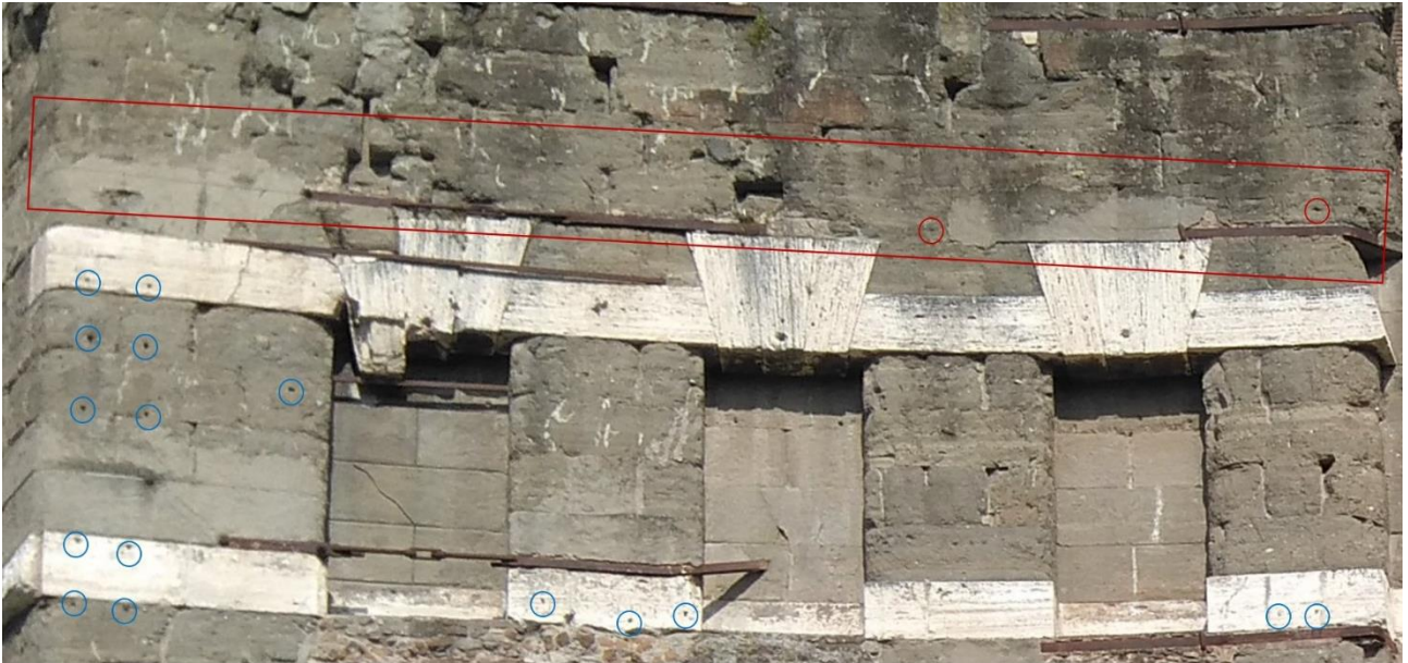
Fig. II.88 Particolare dell'esedra sud. In evidenza i fori per grappa riconducibili al fissaggio dei fusti
