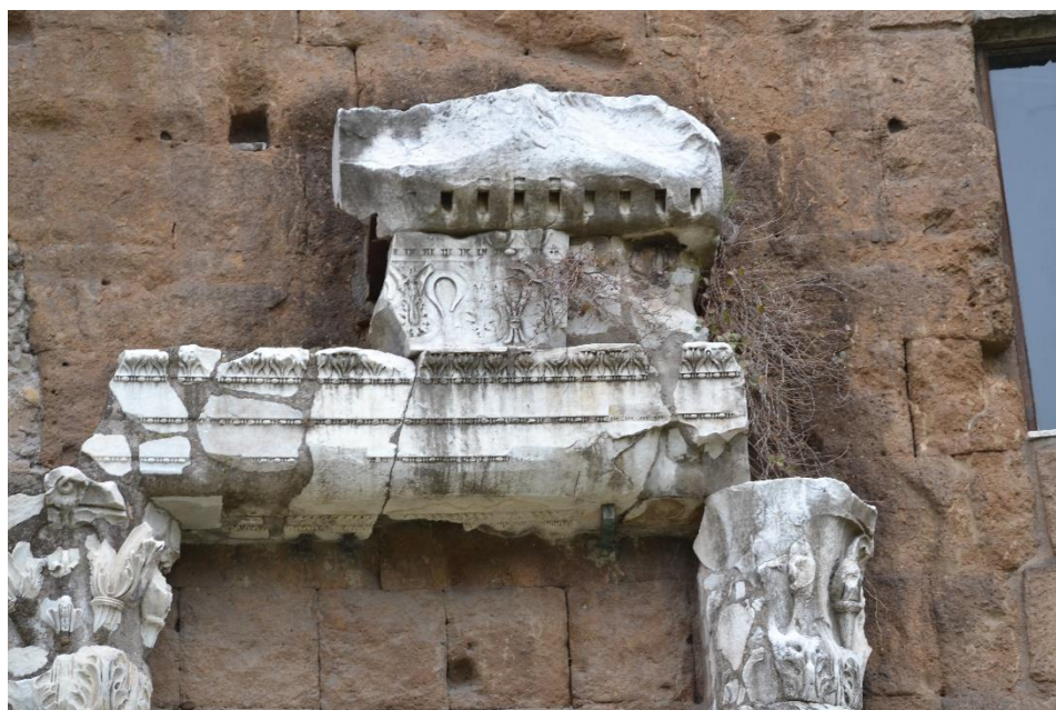
Fig. II.55 Particolare della trabeazione ricomposta nell'edera nord del Foro di Augusto
