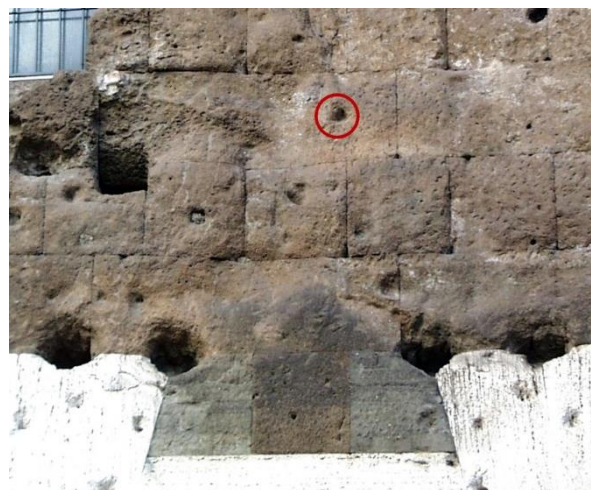
Fig. II.34 Muro dell'edra nord, segmento tra la seconda e la terza piattabanda. In evidenza i fori per grappa riconducibili ai capitelli
