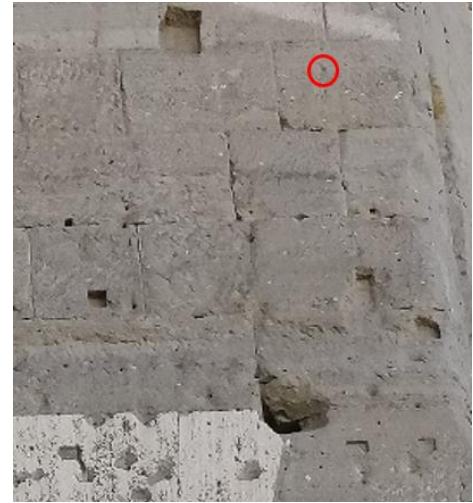
Fig. II.42 Muro di fondo del portico sud. In evidenza il foro per grappa riferibile al fissaggio degli architravi
