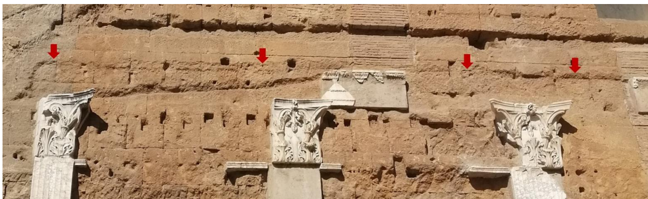
Fig. II.44 Parete nord dell'Aula del Colosso. In evidenza le tracce di lavorazione ed i fori per grappa riferibili al fissaggio degli architravi
