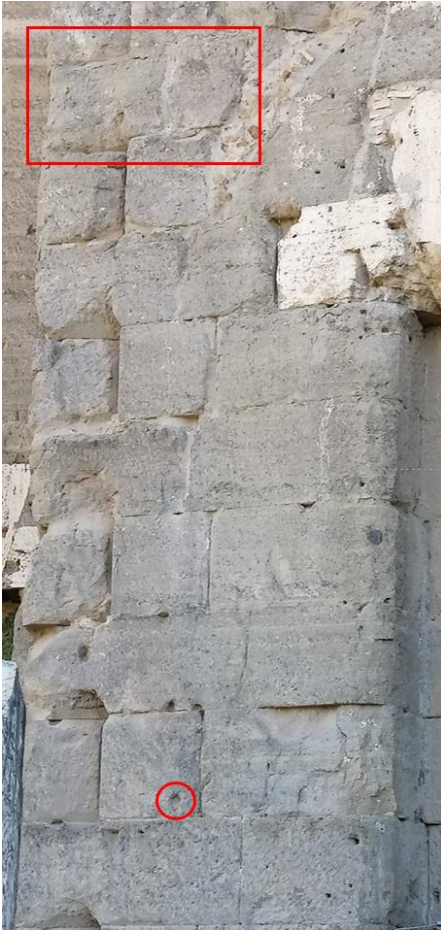
Fig. II.13 Muro dell'esedra, segmento tra l'angolo verso il portico e la nicchia contigua. In evidenza la porzione corrispondente alla sommità del sommoscapo e il foro attribuibile al rocchio di imoscapo
