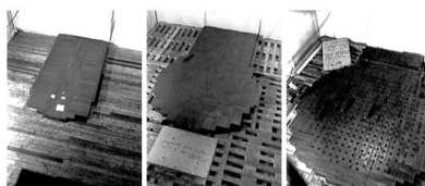
Immagine dall'alto della pila di Fermi in costruzione, sotto un dettaglio
