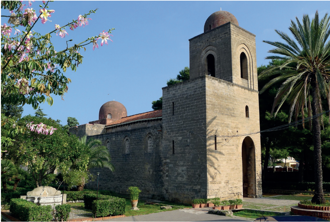
Figure 4 – General view of San Giovanni dei Lebbrosi
