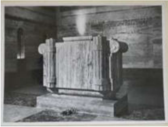
Fig. 237: Dettaglio dell'interno del sacristia ubicato nel coro delle monache nella chiesa di S. Maria alle Cacce (1936). Da: Pavia, Musei Civici, Pinacoteca, inv. fototeca n. 10969. Scatto del 1935, archivio Chiolini-Turconi.
